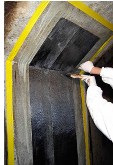
Passage de la spatule
