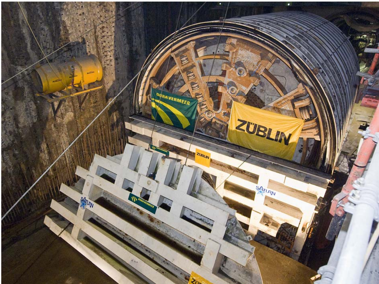
Bild 7: Transfer und Demontage Druckdeckel STS
