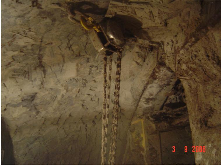
Bild 7 – Mit Kunstboden stabilisierte Kaverne vor einem Schneidrad
