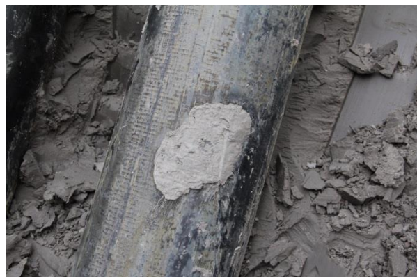
Abbildungen 5 und 6 – freigelegte Injektionskörper bei Rohrschirmrohren. Links: „Rippe“ im Bereich einer sandigen Zwischenschicht. Rechts: unvollständige Verfüllung Ringspalt bei Injektionsventilen
