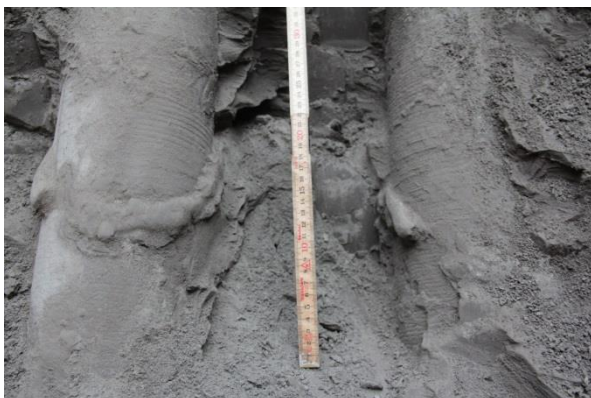
Abbildungen 5 und 6 – freigelegte Injektionskörper bei Rohrschirmrohren. Links: „Rippe“ im Bereich einer sandigen Zwischenschicht. Rechts: unvollständige Verfüllung Ringspalt bei Injektionsventilen
