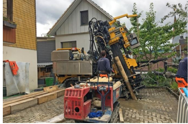
Abbildungen 11 und 12 – Schlammzutritt und ergänzende Sondierungen. Links: Schlammzutritt vom 04.07.2017 (Standbild aus Video). Rechts: ergänzende Sondierungen in bewohntem Gebiet.
