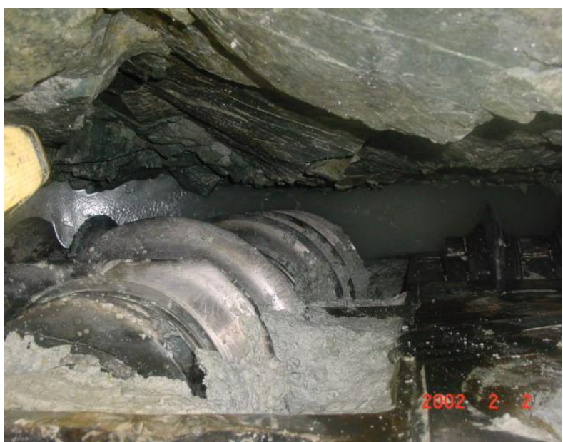
Kein direkter Ortbrustkontakt
