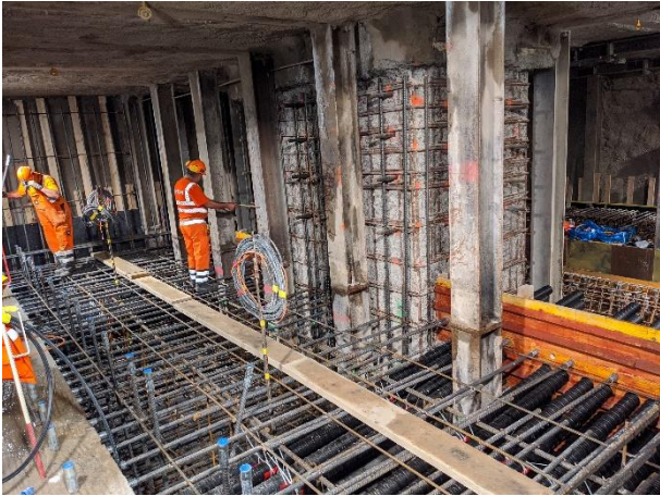
Bild 16: Setzungsmindernde Massnahmen PostParc – links: Bewehrungsarbeiten für den Abfangriegel Süd; rechts: Stirnseite des Abfangriegels Süd [9]
