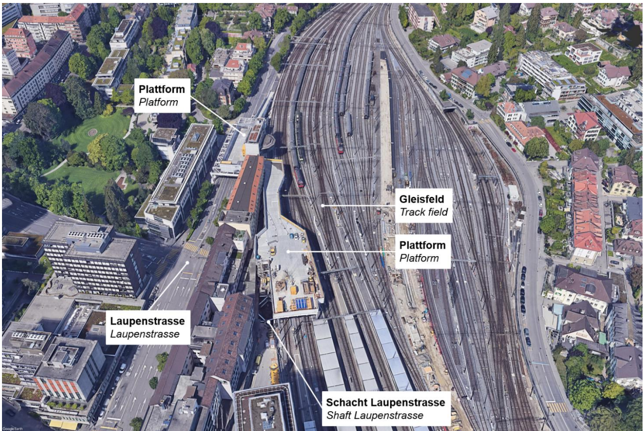
Bild 12: Plattform, Schacht Laupenstrasse und Umgebung (Blickrichtung West) [11]
