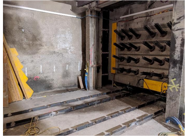
Bild 16: Setzungsmindernde Massnahmen PostParc – links: Bewehrungsarbeiten für den Abfangriegel Süd; rechts: Stirnseite des Abfangriegels Süd [9]
