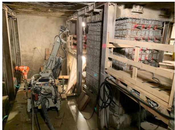
Bild 15: Setzungsmindernde Massnahmen PostParc – links: Vortriebsarbeiten aus dem Posttunnelsystem; rechts: freigelegter ausbetonierter Postliftschacht [9]
