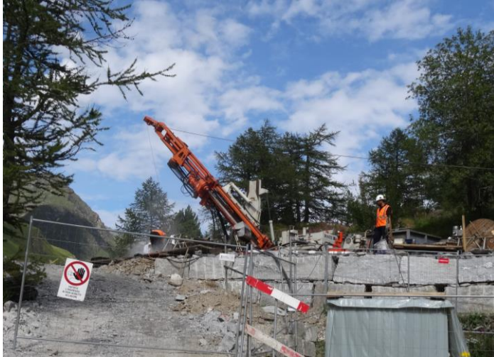
Sondierbohrung SB-05 in Piora Schrägbohrung L = 750 m für einen genauen Aufschluss der geolog. und hydro-geologischen Verhältnisse im Schrägschacht
