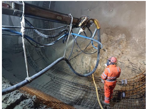
Bild 9: Stollen Laupenstrasse – links: Vortrieb in der Felsstrecke; rechts: Ausbruchsicherung in der Felsstrecke [9]
