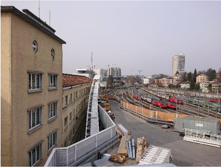
Bild 13: Plattform – links: Plattform mit Förderband; rechts: Herunterlassen Bohrjumbo [9]
