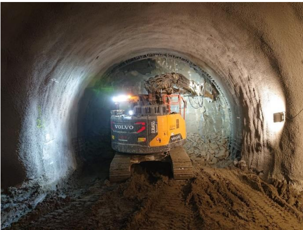
Bild 9: Stollen Laupenstrasse – links: Vortrieb in der Felsstrecke; rechts: Ausbruchsicherung in der Felsstrecke [9]
