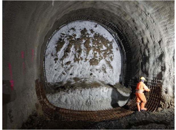
Bild 8: Stollen Laupenstrasse – links: Vortrieb am Anfang der Lockergesteinsstrecke; rechts: Ausbruchsicherung in der Lockergesteinsstrecke [9]
