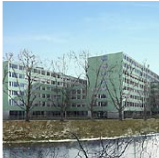
Das Gebäude DL3 auf dem Hürlimann-Areal. (Bild pd)
