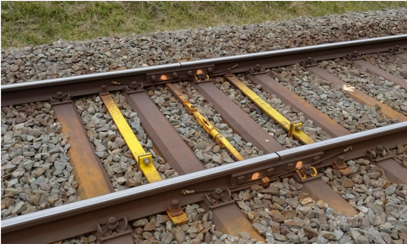
SBB Gleis Le Pont – Le Day, Erneuerung 2018
