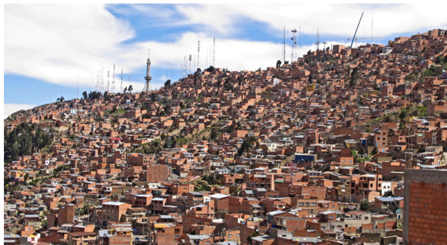
Bild 2: Blick von La Paz zur Kante von El Alto mit Baustelle der Bergstation der Gelben Linie oben rechts.
