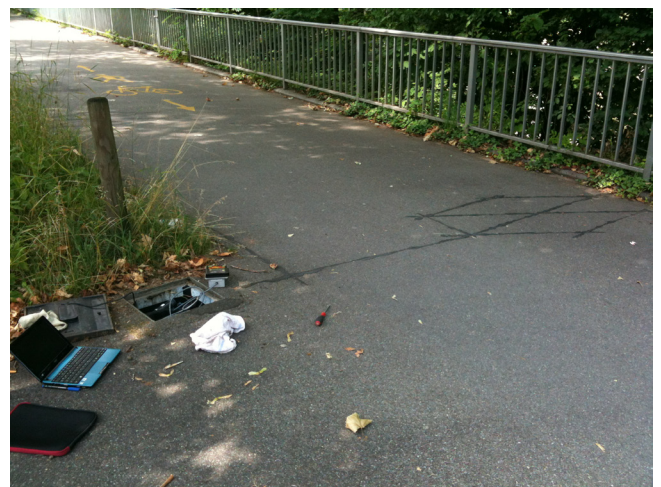
Abb. 6: Wartung der automatischen Velozählstelle an der Sihl-promenade in Zürich. Die Zähl-daten werden mittels GSM-Modem täglich an einen Server übermittelt. Quelle: Stadt Zürich, Tiefbauamt
