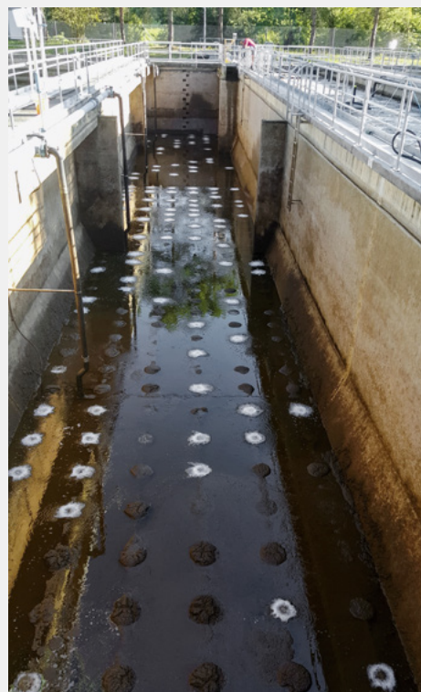
Fig. 6 Beispiel einer Belüftung vor (links) und nach (rechts) dem Membranwechsel. Das Fouling der alten Membranen ist gut ersichtlich. Es sollte mit einer geeigneten Überwachung möglichst frühzeitig erkannt werden.
