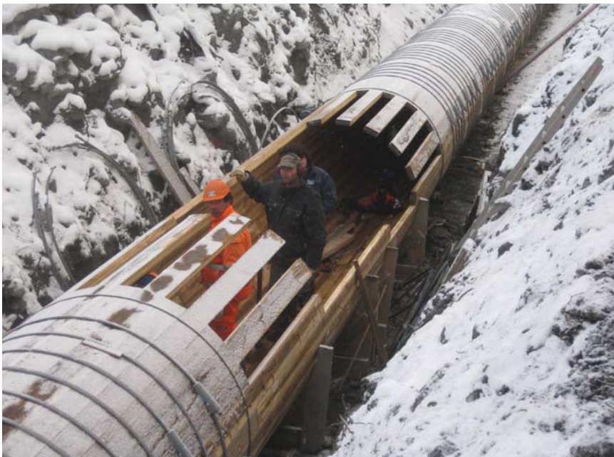
Abb. 40: Baustelle der Holzdruckleitung des KW Taschinas II bei Grüşch.
