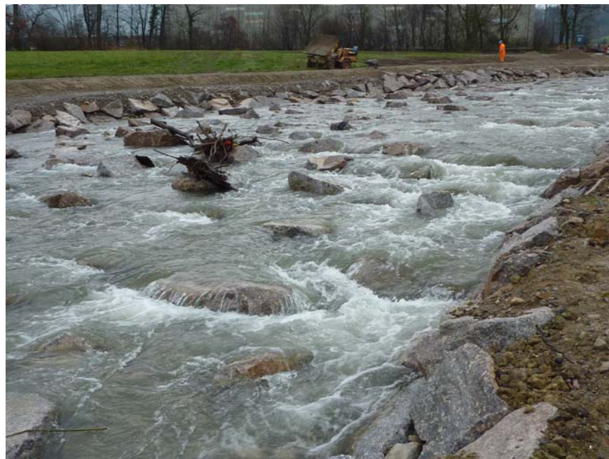
Abb. 19: 2009 gebaute, aufgelöste unstrukturierte Blockrampe an der Wyna, Kanton AG (Quelle: Hunziker, Zarn & Partner, M. Kaufmann).
