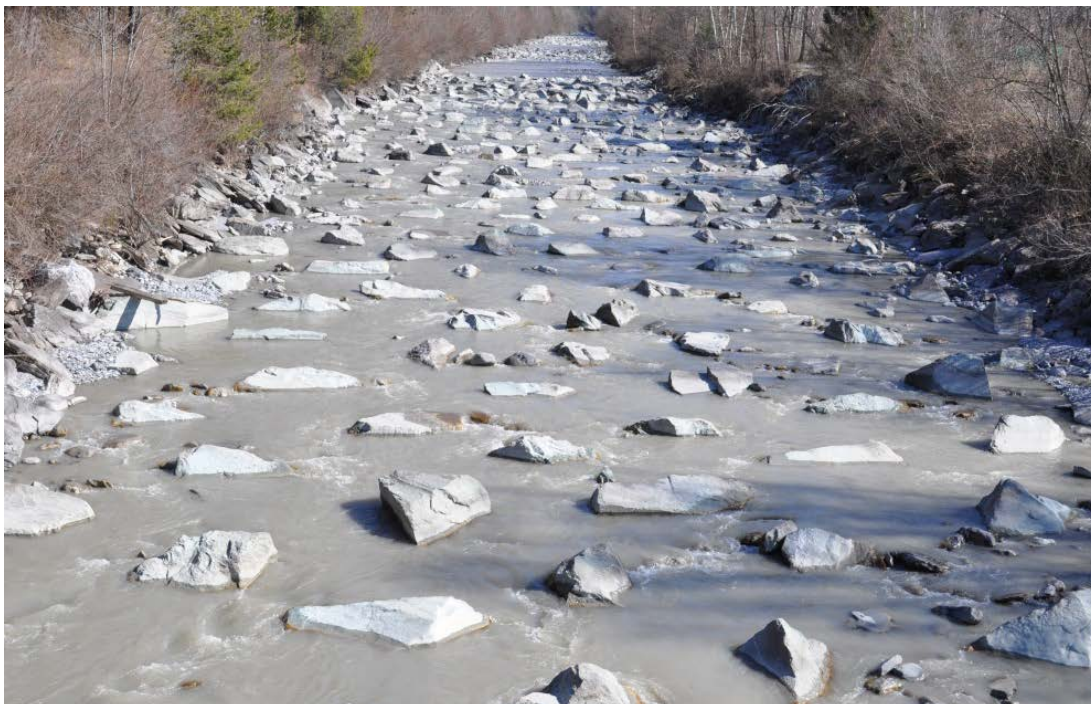
Abb. 23: Rampenserie an der Landquart. Die Blöcke weisen einen Durchmesser von ca. 1.5 m bei einem Gewicht von ca. 4-5 t und eine Belegungsichte von ca. 20% auf.
