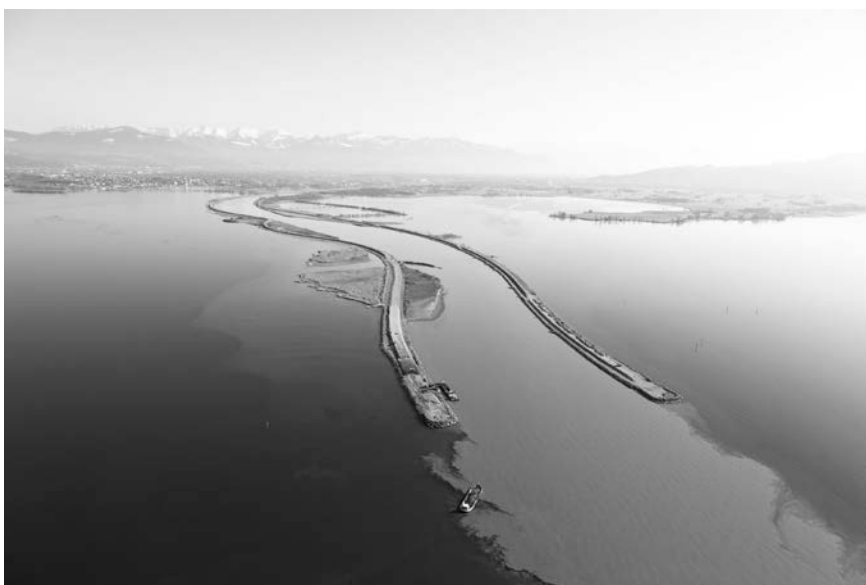
Abb. 36: Heutiger Ausbauzustand der Rheinvorstreckung (Mündung des Alpenrheins in den Bodensee). Deutlich sichtbar ist die aufgrund der Schwebstofffracht verursachte Trübung des einmündenden Flusswassers. (Quelle: IRR)
