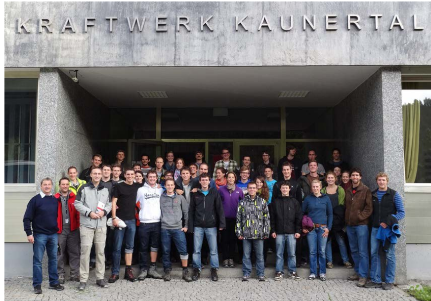
Abb. 46: Exkursion zum Kraftwerk Kaunertal am 16. Oktober 2012.
