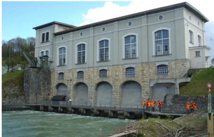
Abb. 45: Exkursion zum Kraftwerk Hagneck am 20. April 2012.
