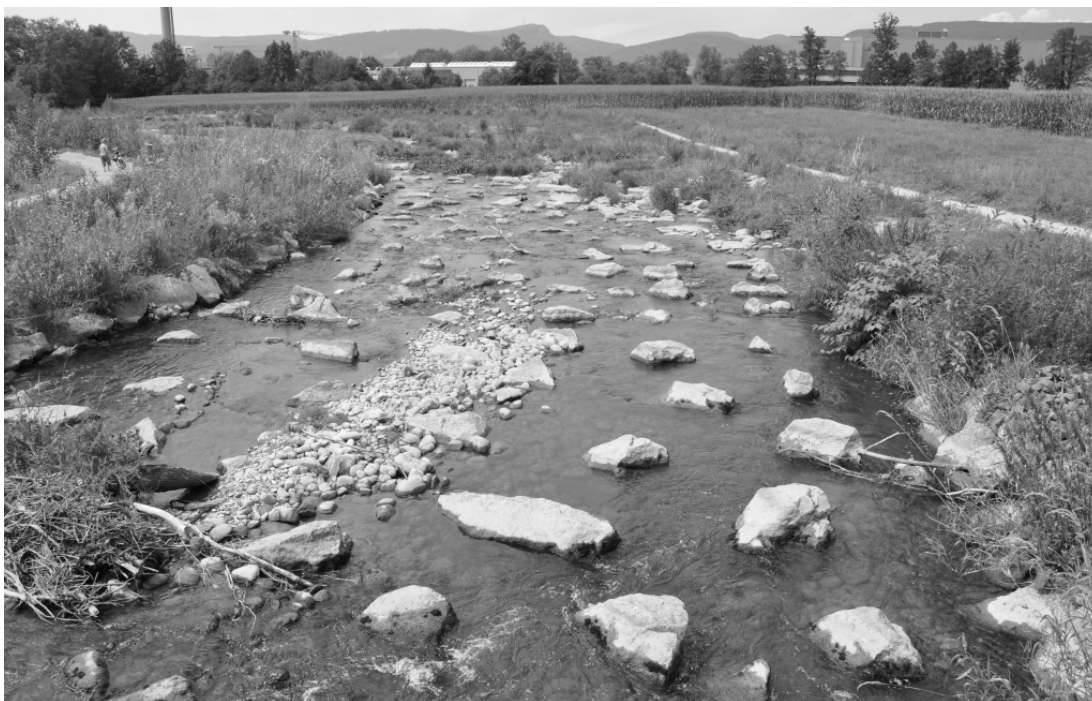
Abb. 27: Aufgelöste unstrukturierte Rampe an der Wyna, die für Naturversuche zur Untersuchung der Fischdurchgängigkeit verwendet wurde.
