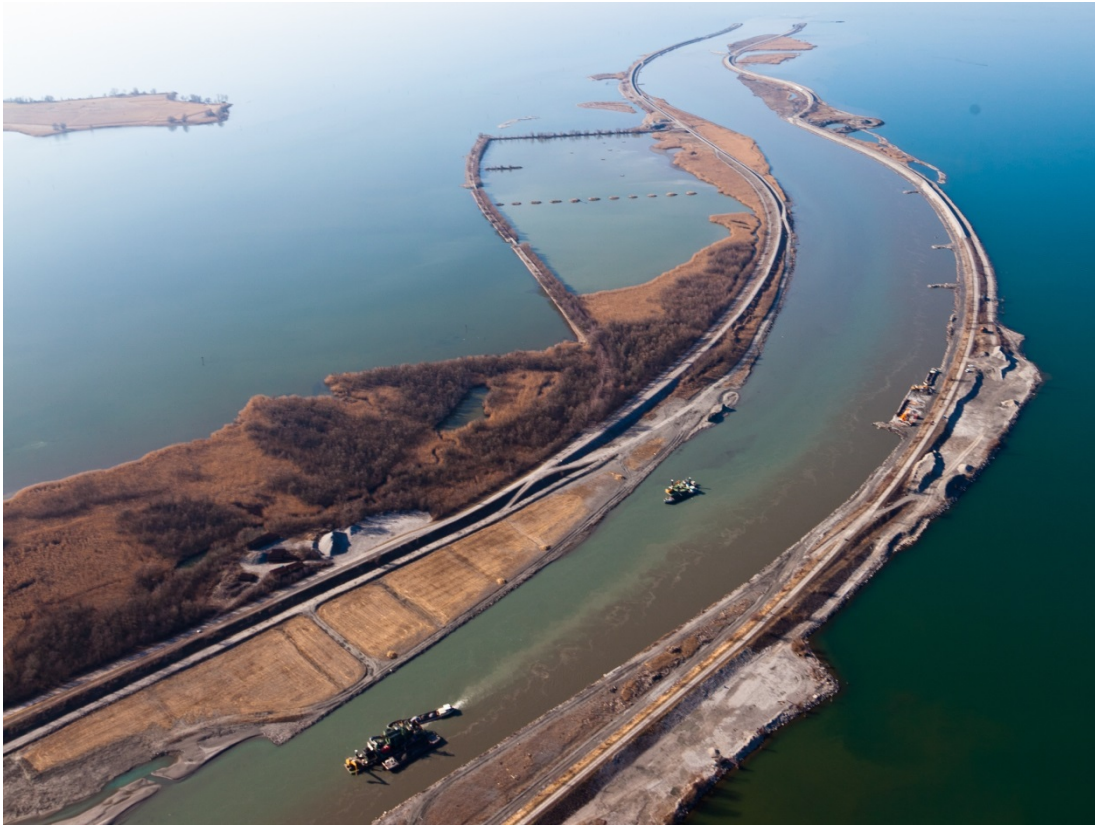
Abb. 22: Rheinvorstreckung (Mündung des Alpenrheins in den Bodensee) mit Bagger-schiffen; Blick in Richtung See (Quelle: IRR).
