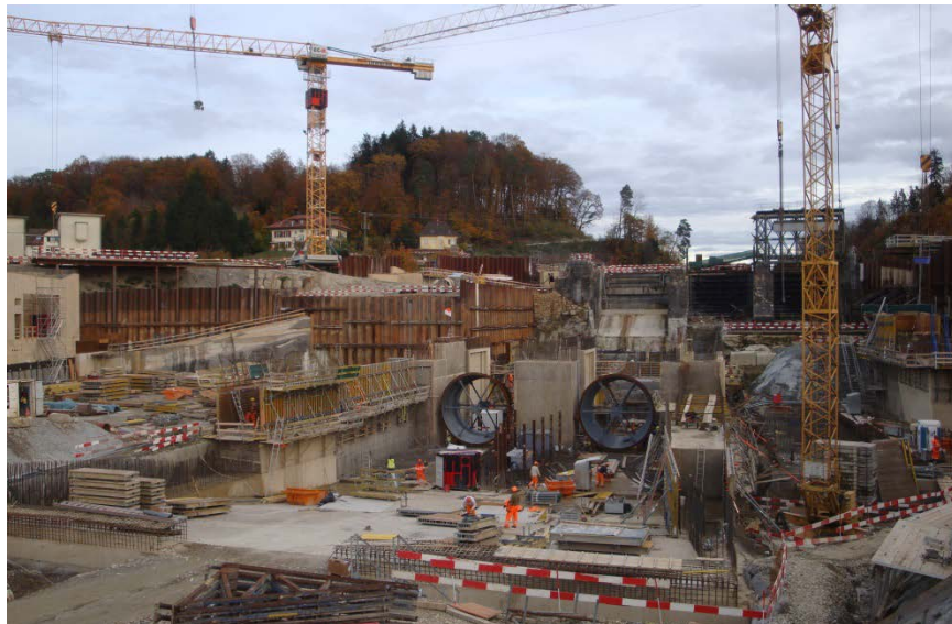
Abb. 33: Exkursion zur Baustelle Flusskraftwerk Hagneck.
