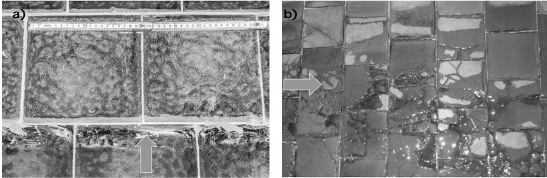
Abb. 8: Detailaufnahmen von Schmelzbasalten: a) Fließrichtung von unten nach oben: Basaltpflasterung im SUS Solis zeigt Abrasionen an den oberwasserseitigen Plattenkanten, b) Fließrichtung von links nach rechts: Basaltpflasterung im SUS Runcahez weist Sprödbrüche und herausgerissene Plattenfragmente auf (Bilder M. Hagmann)
