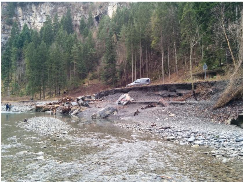
Abb. 22: Seitenerosion in der Albula nach dem Hochwasserereignis vom 13.08.2014 (Foto M. Facchini)
