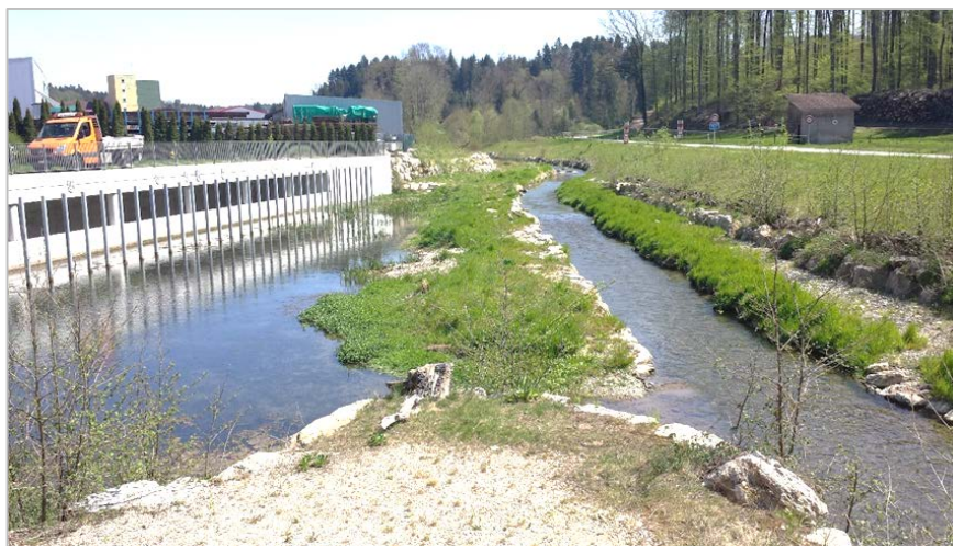
Abb. 39: Exkursion zum Lyssbachstollen, Einlaufbauwerk auf der linken Seite, Blick gegen Fliessrichtung
