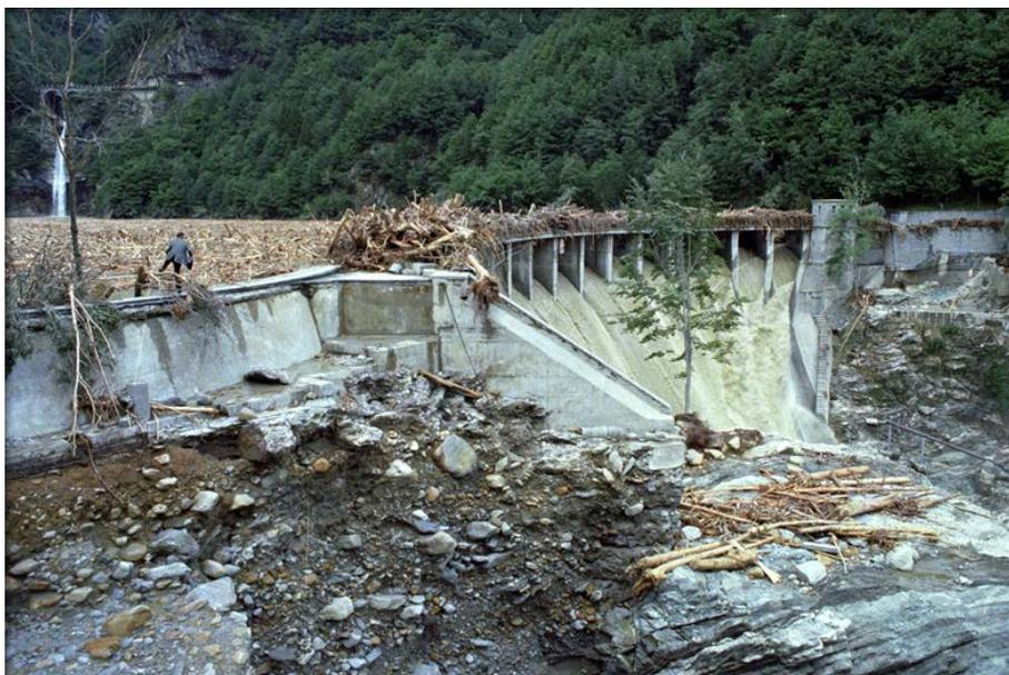
Abb. 26: Verklausung des HWE-Einlaufbauwerks (freier Überfall mit Wehrbrücke) an der Stauanlage Palagnedra, Kanton Tessin, 1978 (Foto: Ofima)
