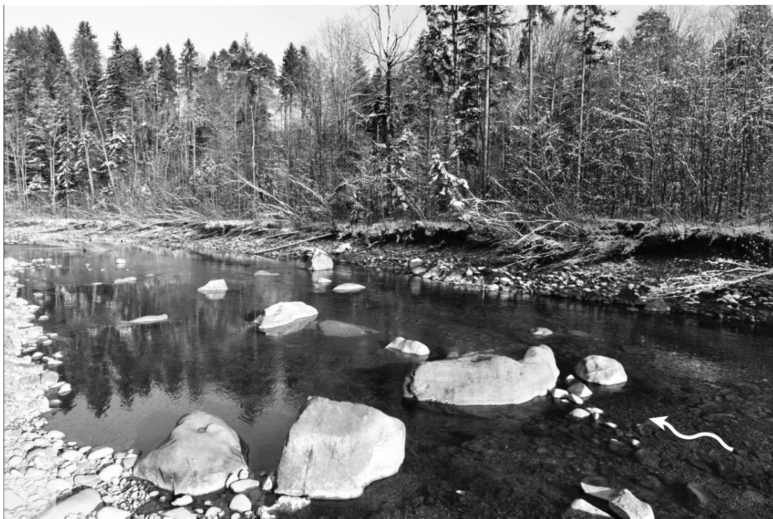
Abb. 13: Ufererosion in der eigendynamischen Aufweitung Augand an der Kander. Als eigendynamisch werden die Aufweitungen bezeichnet, welche maschinell induziert werden, deren weitere Entwicklung aber weitgehend dem Gewässer überlassen wird.
