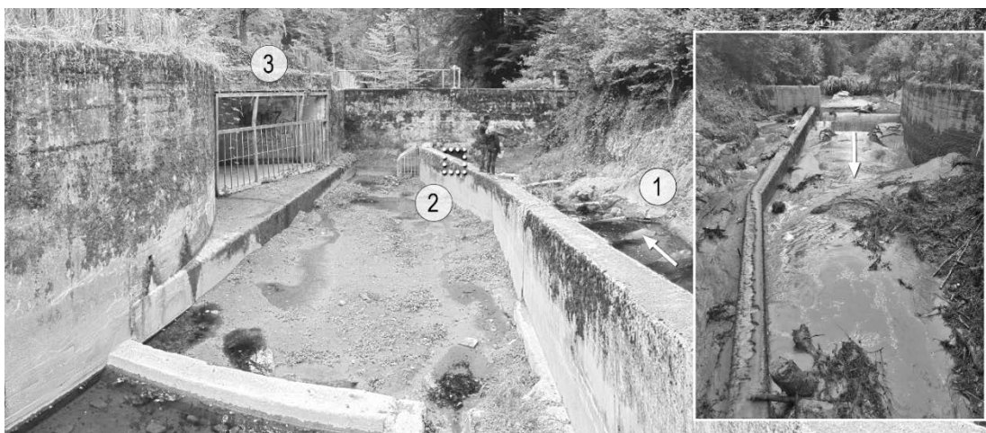
Abb. 16: Ansicht des bestehenden Verzweigungsbauwerks im Würzenbach oberhalb des Luzerner Stadtgebiets; links: Blick in Fliessrichtung mit (1) Fischtreppe, (2) Drosselöffnung in Stauwehr, (3) Einlauf Entlastungsstollen mit Rechen; rechts: Situation bei Starkregenereignis 2015, Blick gegen Fliessrichtung.
