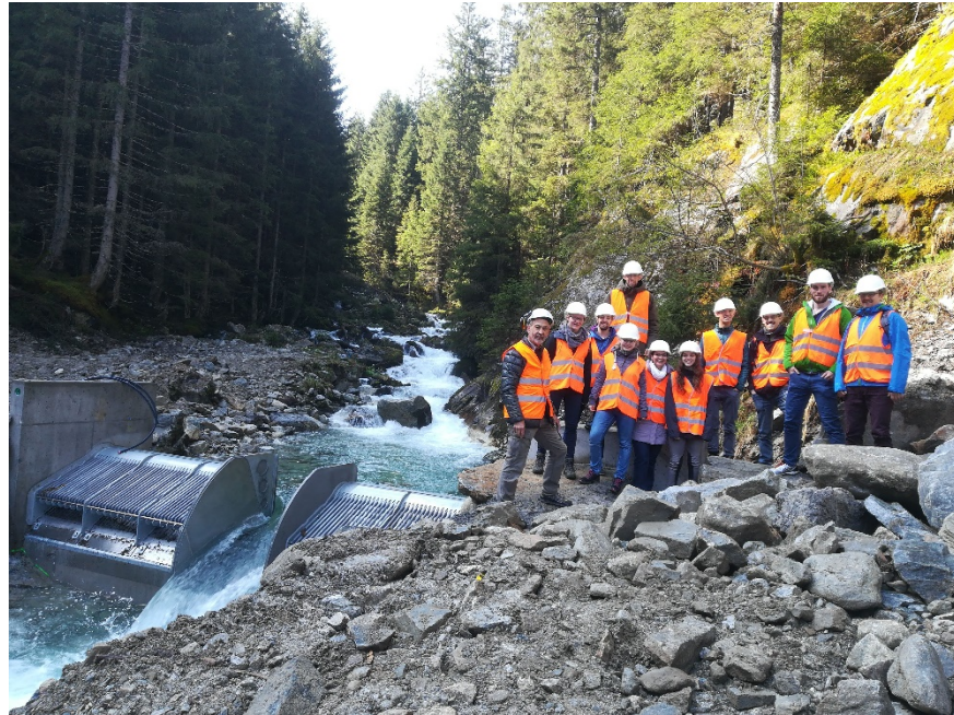
Abb. 27: Besichtigung der Coanda-Fassung des Klein-WKW Fellitobel im Frühjahrssemester 2018 mit 18 Studierenden (6. Bachelorsemester) der Studiengänge Bau- und Umweltingenieurwissenschaften
