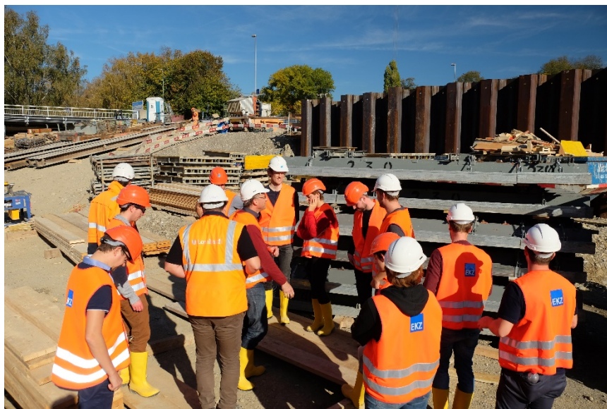
Abb. 29: Besichtigung des trockengelegten OW-Kanals des KW Dietikon (ekz) im Herbstsemester 2018 mit 10 Studierenden (3. Mastersemester) der Studiengänge Bau- und Umweltingenieurwissenschaften
