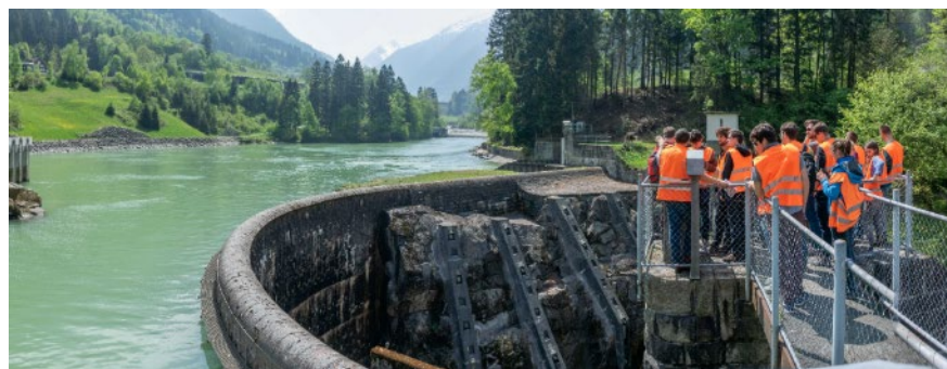
Abb. 28: Besichtigung der Staumauer Pfaffensprung im Frühjahrssemester 2018 mit 18 Studierenden (6. Bachelorsemester) der Studiengänge Bau- und Umweltingenieurwissenschaften
