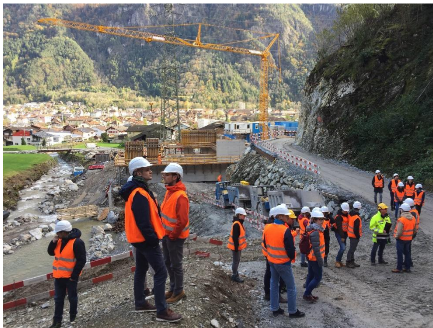
Abb. 27 Besichtigung der Baustelle des KW Erstfeldertal (EWA) im Herbstsemester 2019
