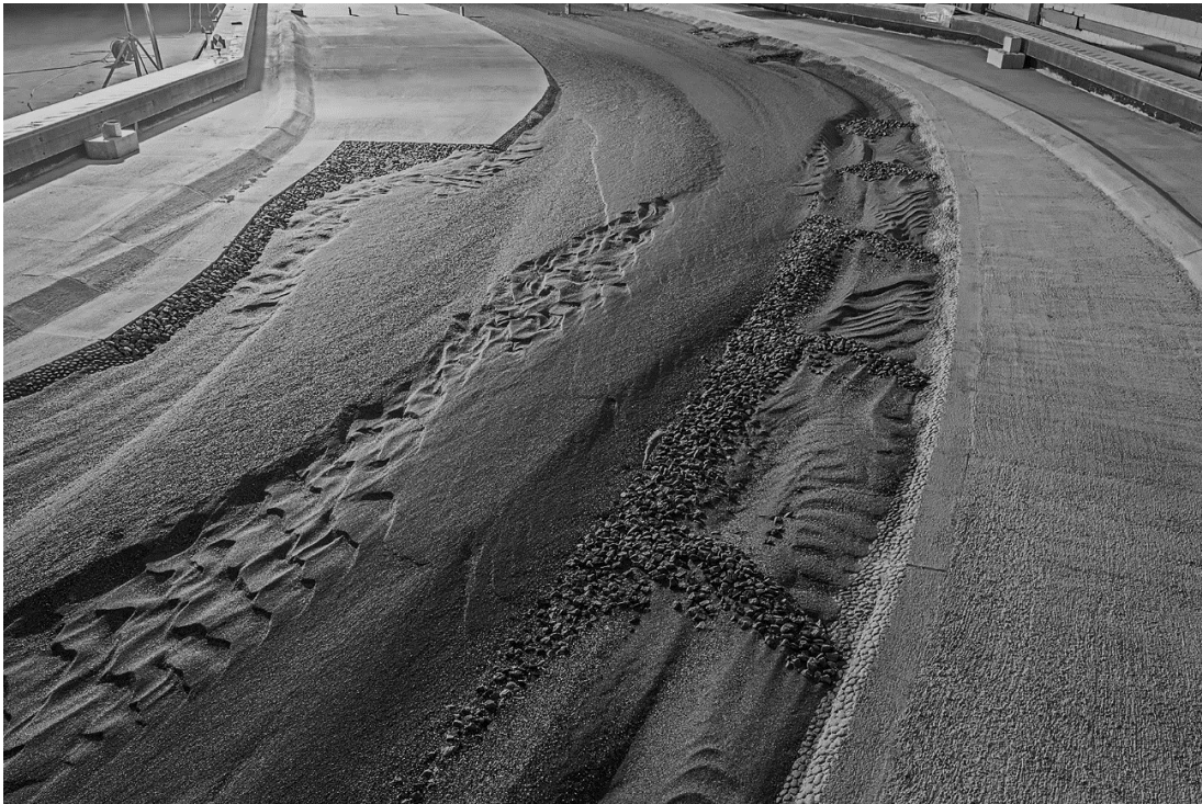
Abb. 8 Sicherung eines Prallufers durch Sichelbuhnen mit Rollierung, Blick gegen die Fliessrichtung; am rechten Ufer Vorlandversatz als ökologische Strukturierungsmassnahme.
