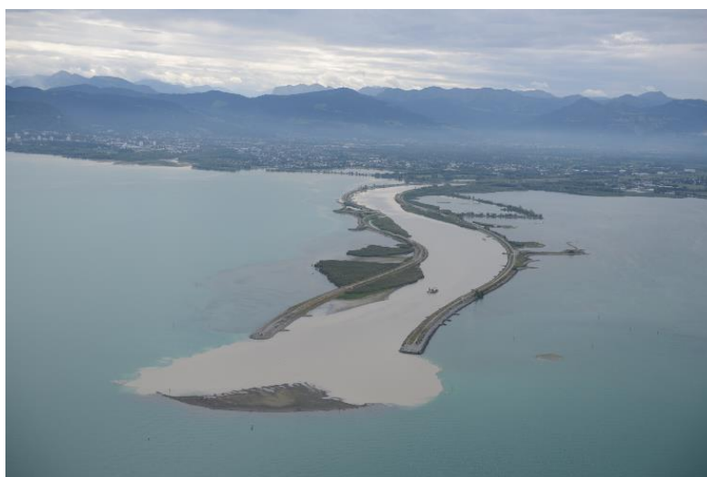
Abb. 13 Rheinvorstreckung mit Sedimentablagerungen an der Mündung im Sommer 2018 (Foto: Internationale Rheinregulierung, 24.08.2018)
