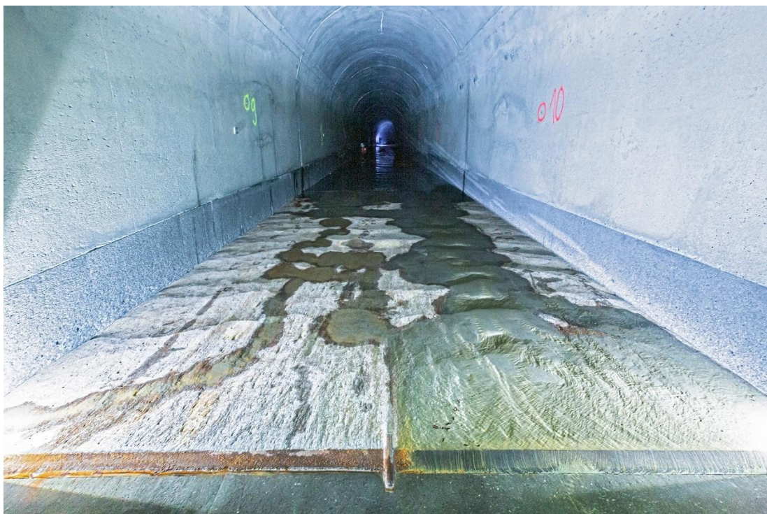
Abb. 3 Testfeld F4 im Umleitstollen Solis, Januar 2021
