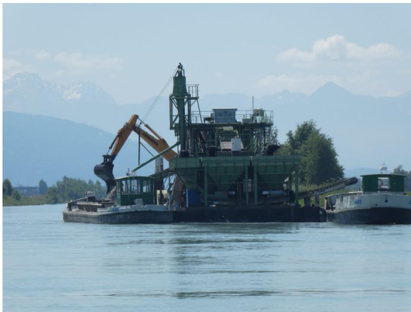
Abb. 12 Kiesentnahme in der Rheinvorstreckung (Foto: C. Leuch, VAW, 2020)
