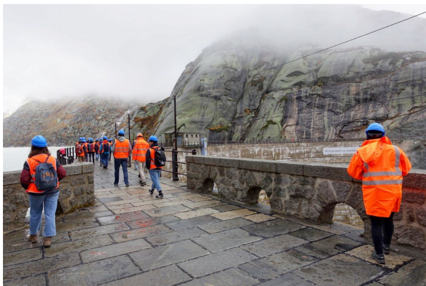
Abb. 32 Besichtigung der Baustelle des Ersatzneubaus Spittallammsperre im Herbstsemester 2021 (Foto: Besichtigung der Baustelle von der alten Mauerkrone aus).
