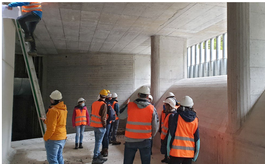
Abb. 31 Besichtigung der Baustelle des Würzenbachstollens in Luzern im Frühjahrssemester 2021.
