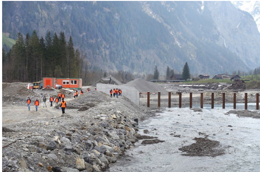
Abb. 30 Besichtigung des Geschiebesammlers an der Engelberger Aa im Frühjahrssemester 2021.
