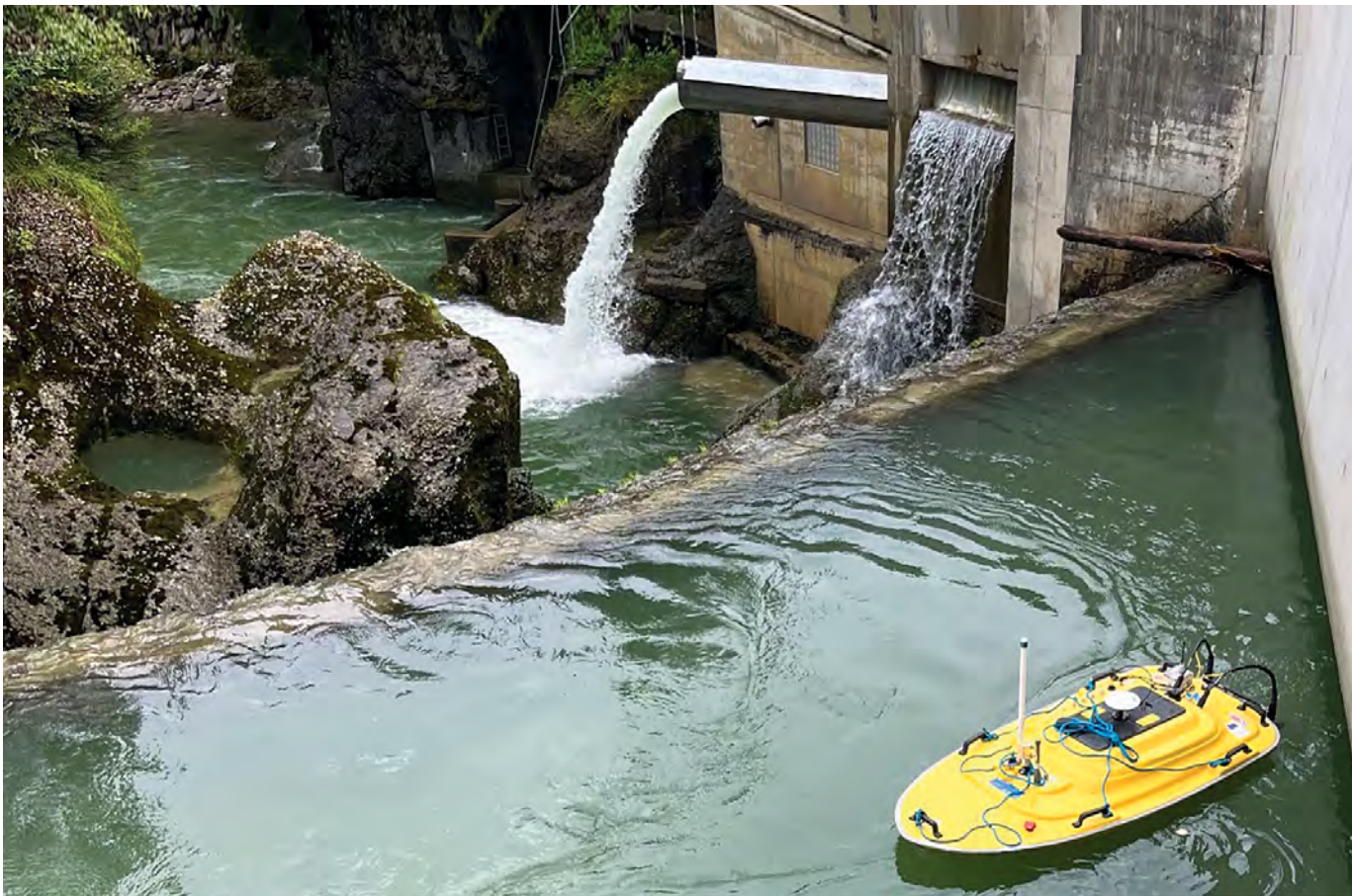
Abb. 1: Das ferngesteuerte Q-Boot ausgestattet mit einem ADCP-Sensor unmittelbar vor dem Wehr im Zulauf des KW Herrentöbeli. Rechts im Bild ist die oberstrom des f-CBR angeordnete Tauchwand und im Hintergrund der Bypassausstieg zu erkennen.
