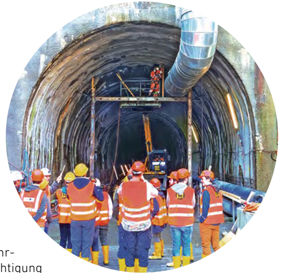
Abb. 21 Besichtigung der Baustelle des Entlastungsstollens Sarneraa (OW)
