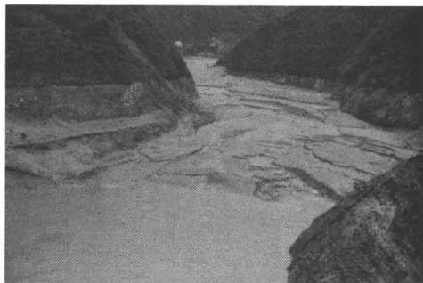
Foto 1: Absenkvorgang auf der Seite Aracay. Verlandung vor Beginn der eigentlichen Spülung
