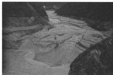
Foto 2: Absenkvorgang auf der Seite Aracay. Das Abgleiten des Sedimentationskegels ist deutlich sichtbar
