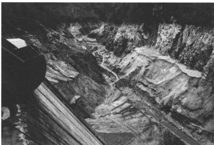
Bild 4: Gespültes Becken bergwärts der Wasserfassung. An beiden Ufern sind die Spuren der Auflandung deutlich zu sehen.
