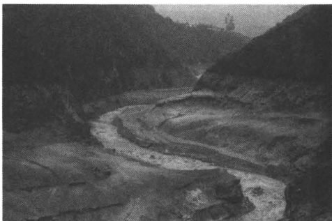
Foto 7: Seite Santo Domingo. Zustand des Reservoirs nach einer Spülung von 3 Tagen Dauer
