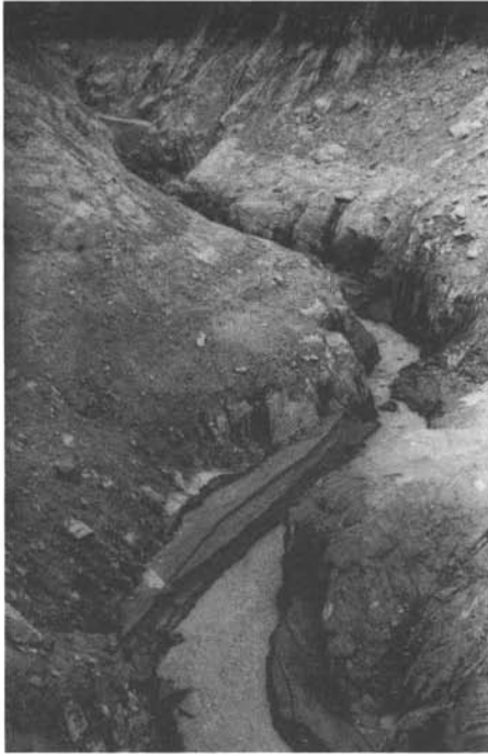
Bild 7 Blick von der Mauer in den entleerten Stauraum. Das Wasser ist im Begriff, die noch vorhandenen Geschiebe wegzuerodieren. Der Spiegel steht bei vollem See am oberen Bildrand.
