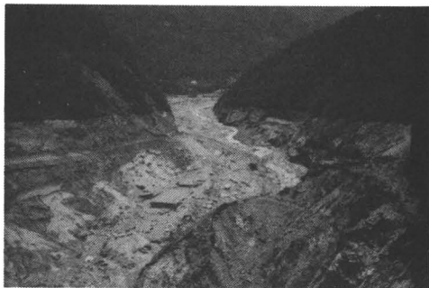
Foto 5: Seite Aracay. Zustand des Reservoirs vor dem Beginn des Wiederaufstaus (nach 3 Wochen Spülung)
