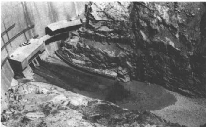
Bild 6 Talseite der Mauer mit Grundablass nach Beginn einer Spülung
