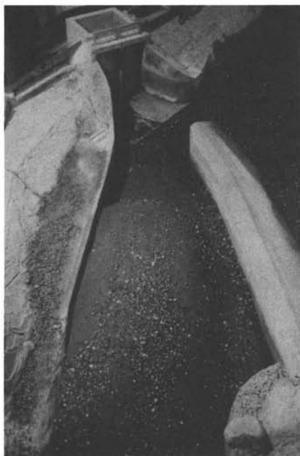
Bild 5. Vordringende Auflandung in der Nähe der Einlaufschwelle
