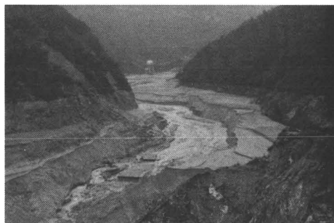
Foto 3: Seite Aracay. Zustand des Reservoirs nach einer Spülung von 3 Tagen Dauer (Blick von der Sperre flussaufwärts)
