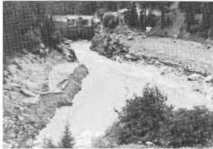
Abbildung 3.24 Wehr und unterer Staubereich des Ausgleichsbecken Ferrera während der Spülung vom 6. August 1985. Restbestände der äusseren Kolmation. Blick in Fliessrichtung. Foto aus Kraftwerke Hinterrhein AG (1985).
