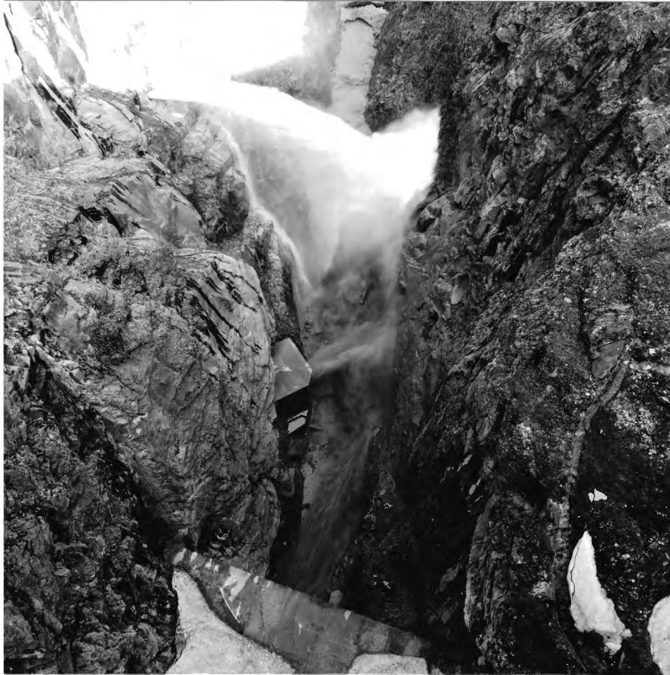
Photo 1: Blick von der Sperre Möll in die Schlucht beide Grundablässe sind 30% offen, links die Reinwasserzugabe
