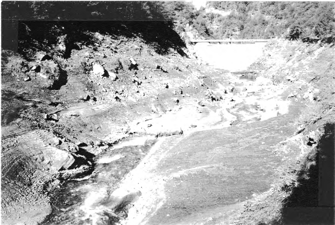
Figur 3: Übersicht der Stauhaltung Morobbia am Ende einer Spülung kurz vor dem Wiederaufstau.
