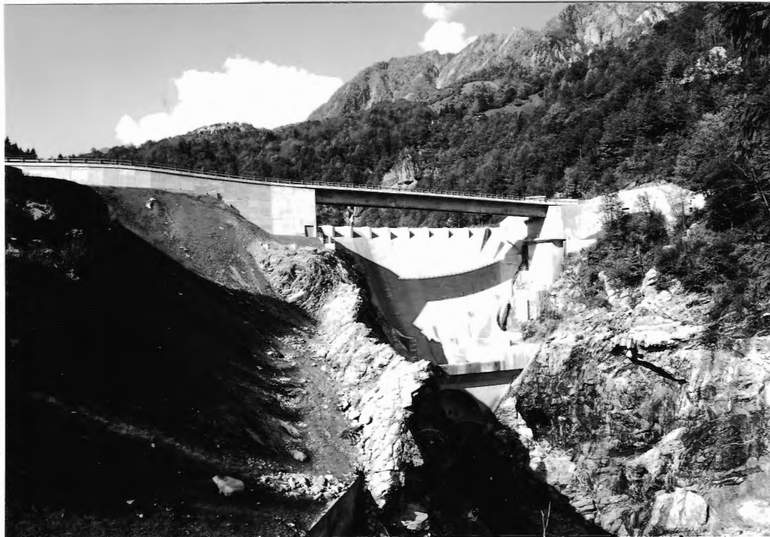
Bild 2 Staumauer Palagnedra - Umgebaute Hochwasserentlastung und Brücke
