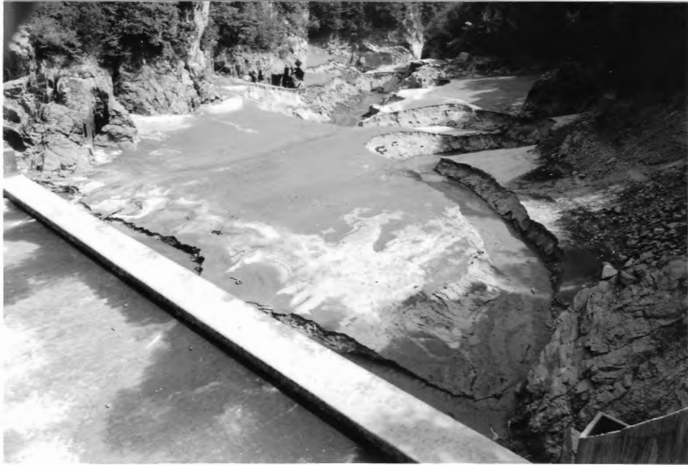
Bild 5 Verlandungen mit Feinmaterial unterhalb der Zwischensperre
