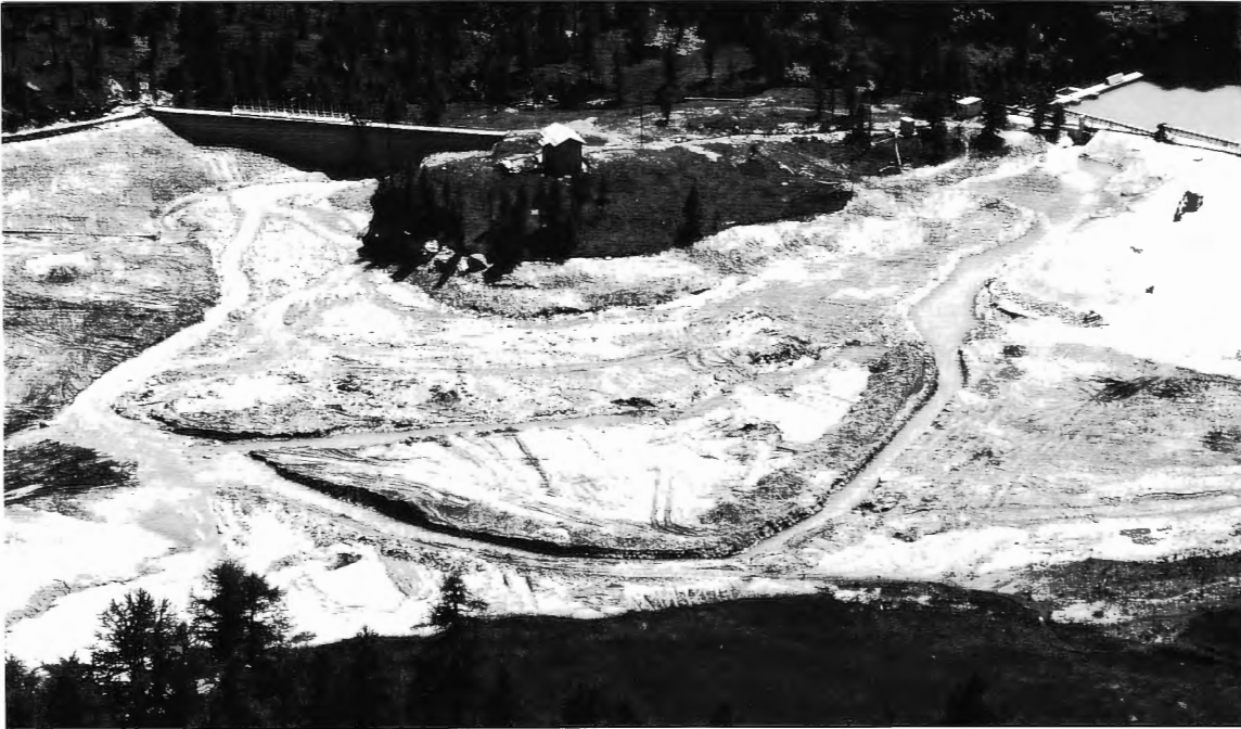
Abbildung 11: Das abzubauen Material wird zunächst von einem Raupentrax in die Nähe des umgeleiteten Palübachs gestossen, von wo es der Bagger in den Bach wirft.
