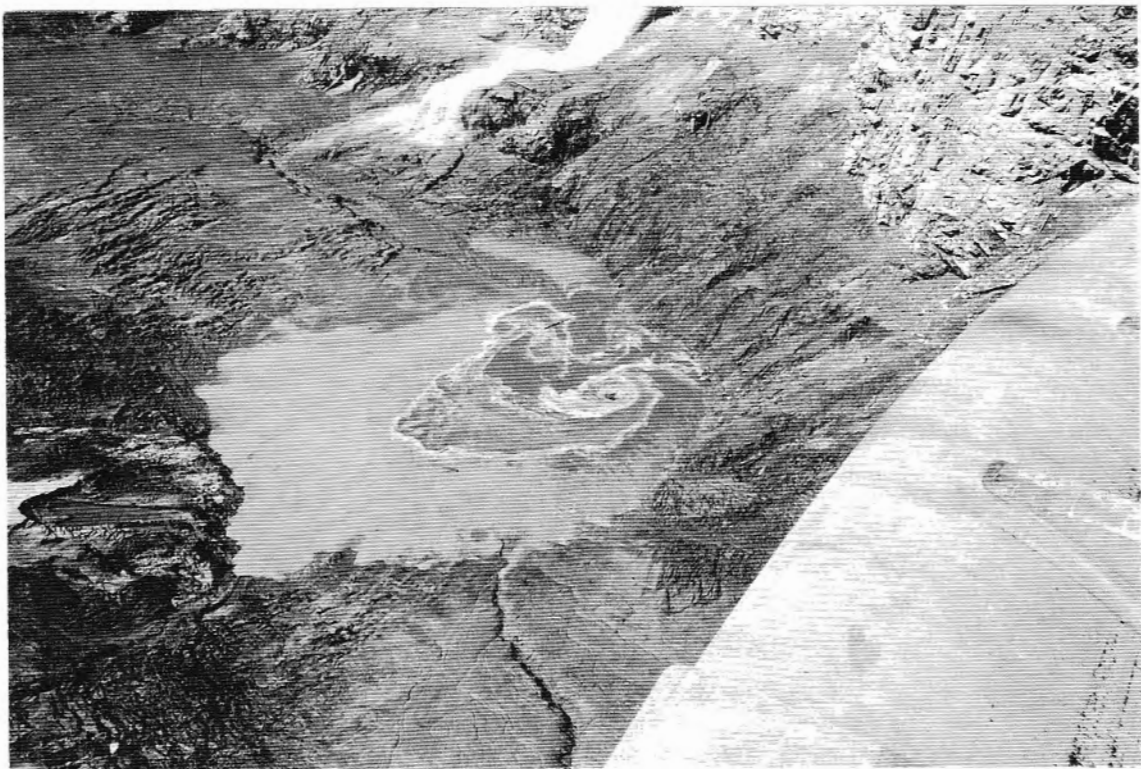
Bild 7 Stauraumpülung am 10. September 1991 Schlussphase der Beckenentleerung beim Eintreffen des Betriebswassers der Zentrale Cavergho
