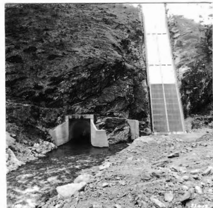
Bild 4. Wasserfassung und Grundablass
