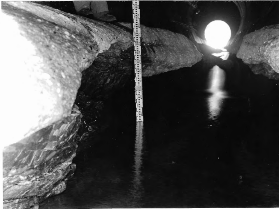
Bild 3 Spülstollen Palagnedra Erosionserscheinungen in der Stollensohle kurz vor dem Stollenauslauf (Tiefe 2.70 m)
