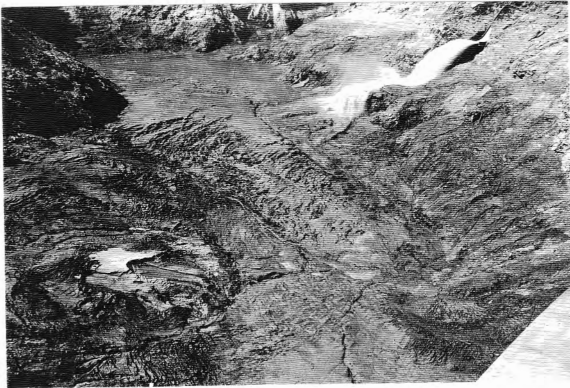
Bild 8 Anfangsphase der Stauraumspülung am 10. September 1991 Durch die Zuführung des Betriebswassers der Zentrale Caveragno bewegt sich das abgelagerte Feinmaterial "murgangähnlich" auf den Grundablassseinlauf zu.
