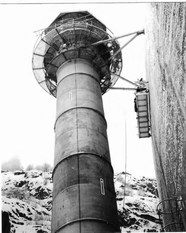
Abb. 10 Teilweise fertiggestellte erhöhte Wasserfassung (obere 20 m). Die Skala wird von der Leiter gegeben
