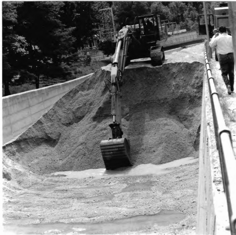
Bild 2: Ansicht der Ablagerungen im Spülkanal nach der Spülung von 1992.
