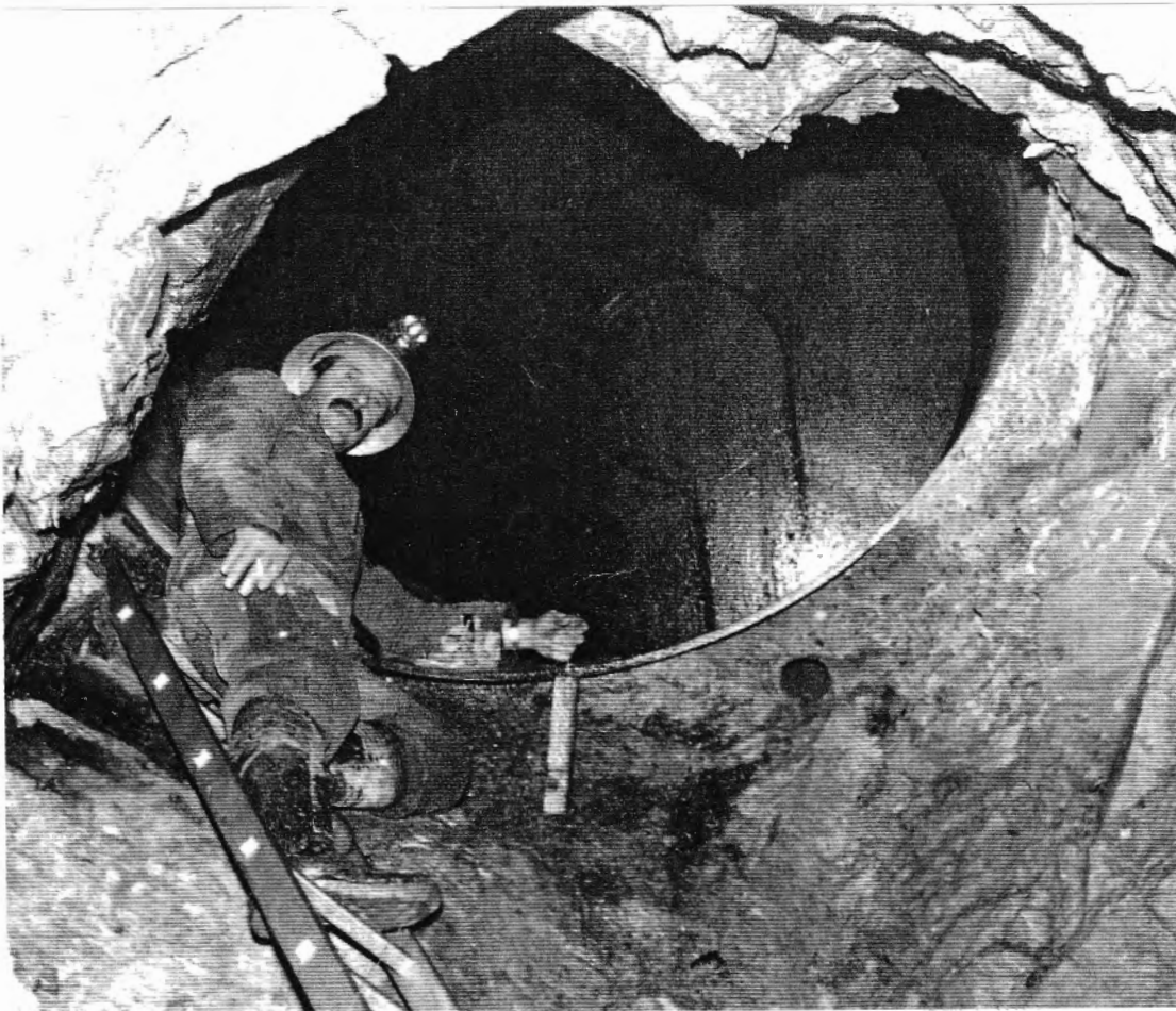
Bild 12. Durchschlag des Felszapfens und Verbindung mit dem einbetonierten Einlauftrichter
