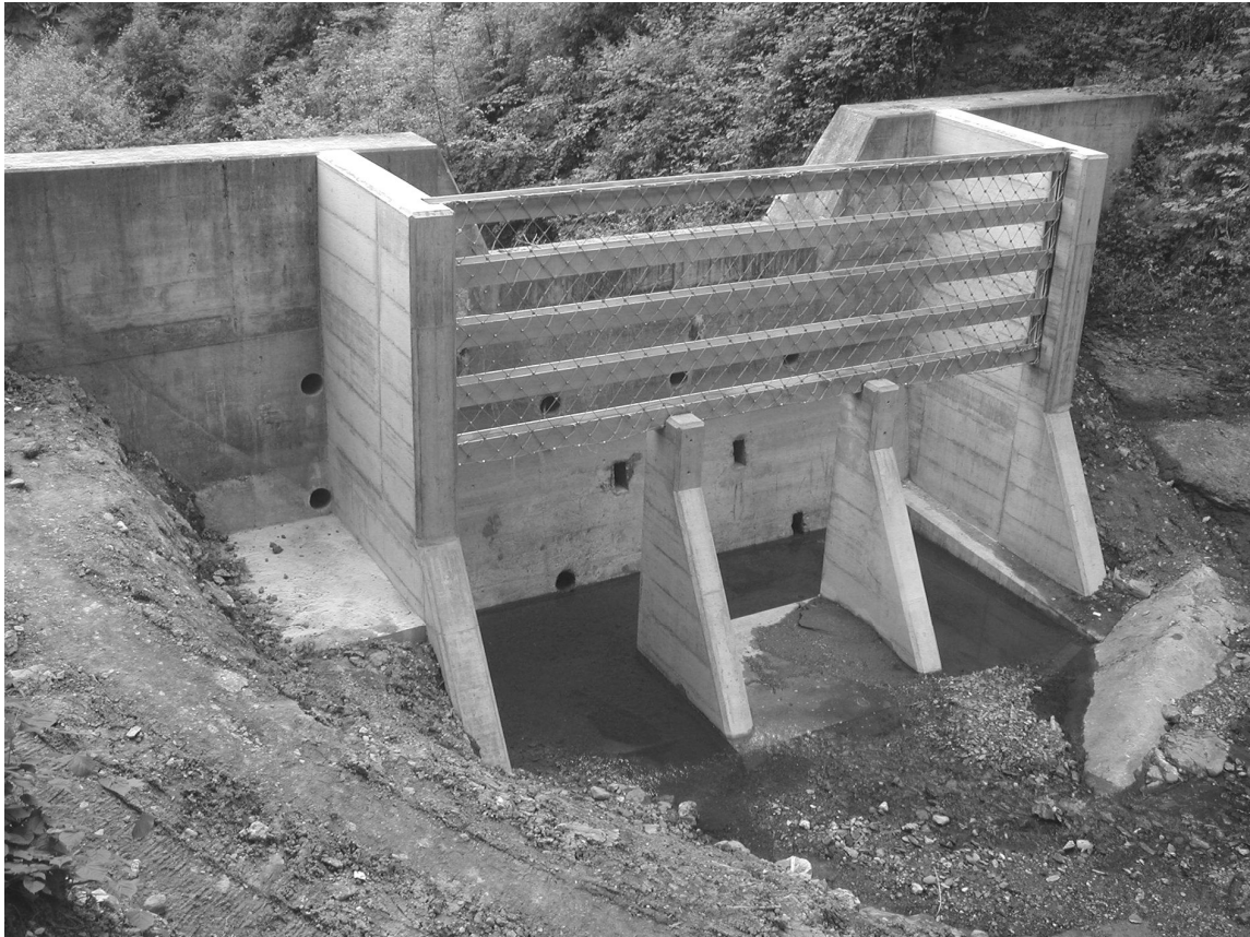
Abb. 49: Tauchwand am Bitzighoferbach (Quelle: Amt für Wald und Raumentwicklung, Abteilung Naturgefahren des Kantons Obwalden)
