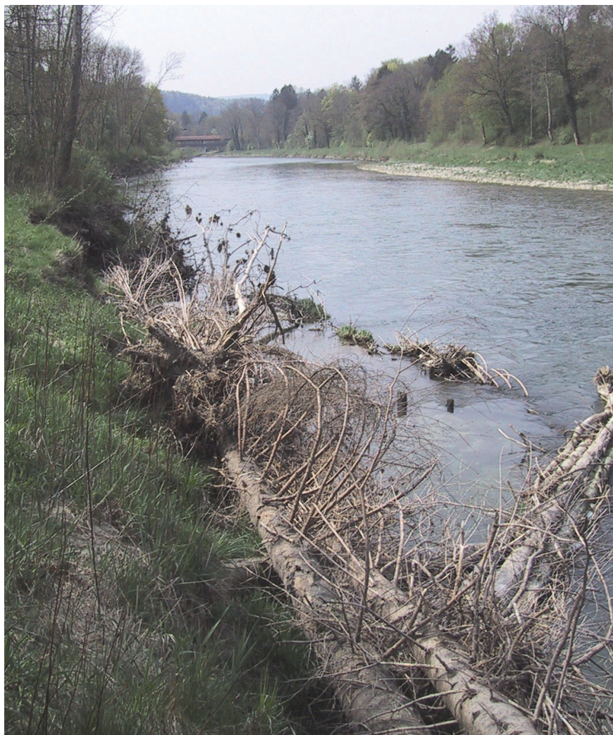
Abb. 4: Raubäume zum Uferschutz an der Thur unterhalb von Andelfingen (Blick in Fliessrichtung)
