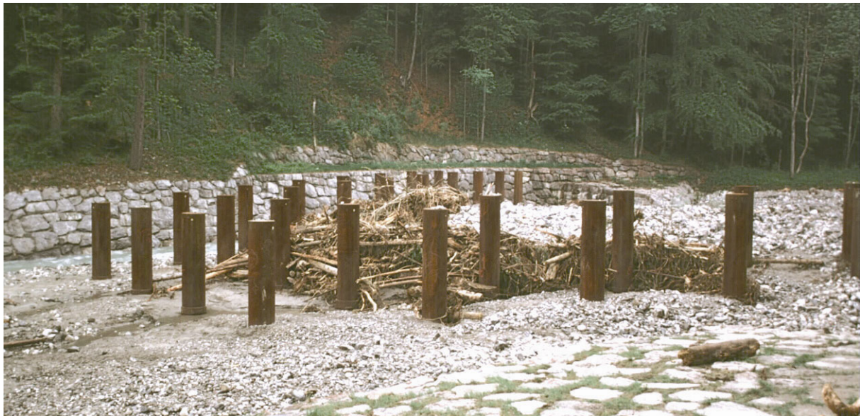
Abb. 30: V-förmiger Schwemmholzrechen am Lainbach (Bayern) mit doppelter Säulenreihe (Lichte Weite zwischen der ersten Säulenreihe 3.40 m) (Quelle: Versuchsanstalt für Wasserbau und Wasserwirtschaft, Oberrach)
