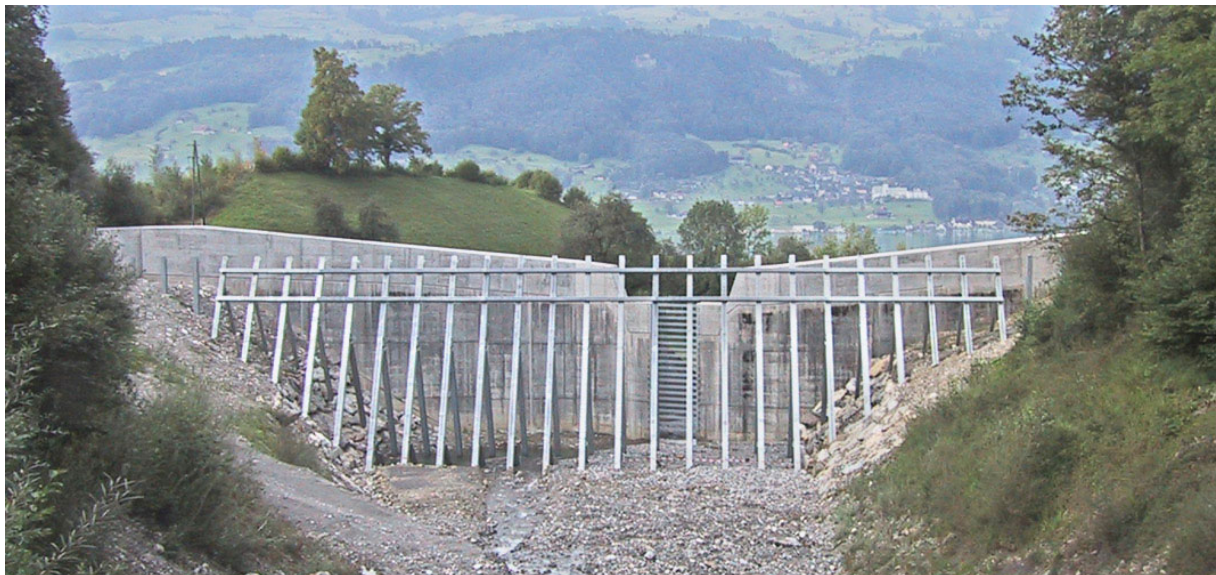
Abb. 78: Holzurückhalterechen an der Abschlussmauer des Geschiebesammlers am Edisriederbach
