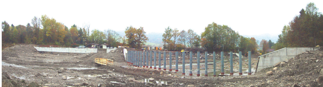
Abb. 75: Kombierter Holz- und Geschieberückhalt mit Rechen und Tauchwand an der Gürbe bei Wattenwil (oben: Modell, unten: Realisiertes Projekt)
