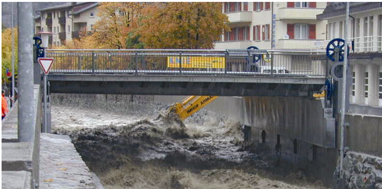
Abb. 23: Angehobene Hubbrücke in Brig beim Hochwasser im Oktober 2000 (Blick in Fliessrichtung) (Quelle: A. Burkard, Brig-Glis)
