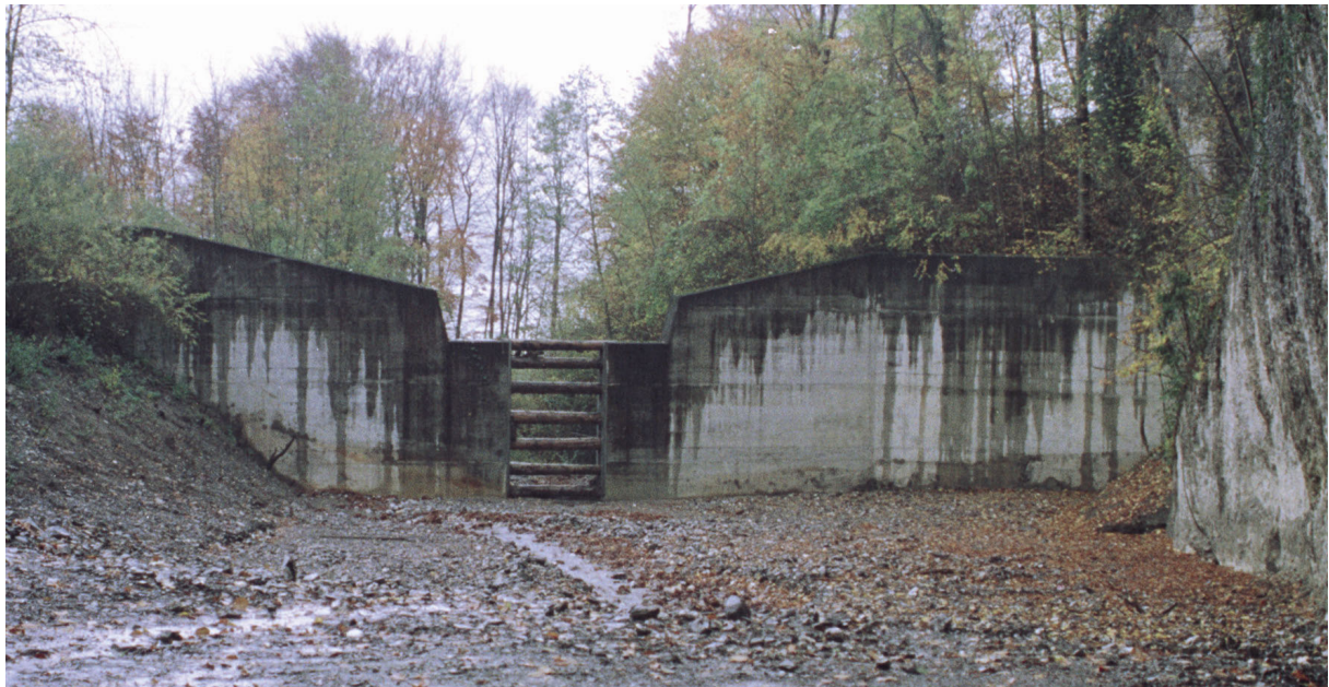
Abb. 33: Balkensperre am Abschlussbauwerk des Geschiebesammlers am Sigetsbach in Sachseln, Abstand der horizontalen Gitterstäbe ca. 50 cm (Blick in Fliessrichtung)
