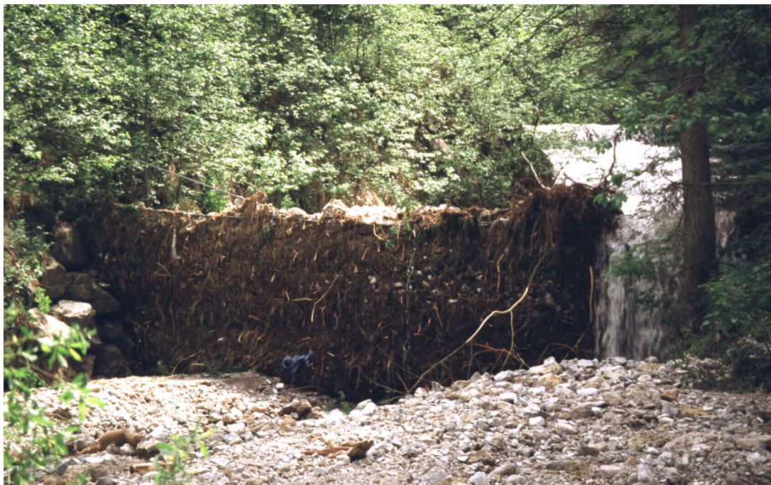
Abb. 56: Beaufschlagtes Schwemmholznetz am Faulengraben (Oberbayern), Blick gegen die Fließrichtung (Quelle: Versuchsanstalt für Wasserbau und Wasserrwirtschaft der TU München)
