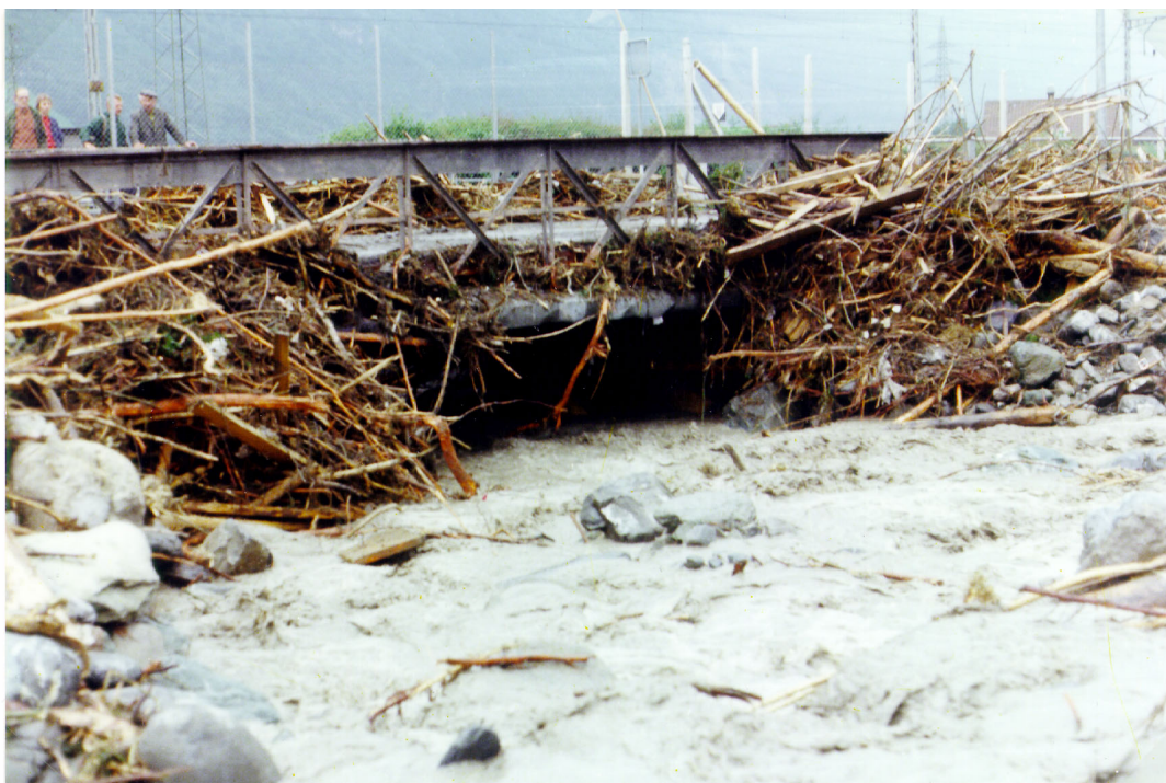
Abb. 1: Holzverklausung an einer Brücke im Mündungsbereich des Schächen beim Hochwasserereignis im Jahr 1977 (Quelle: Amt für Tiefbau, Kanton Uri)
