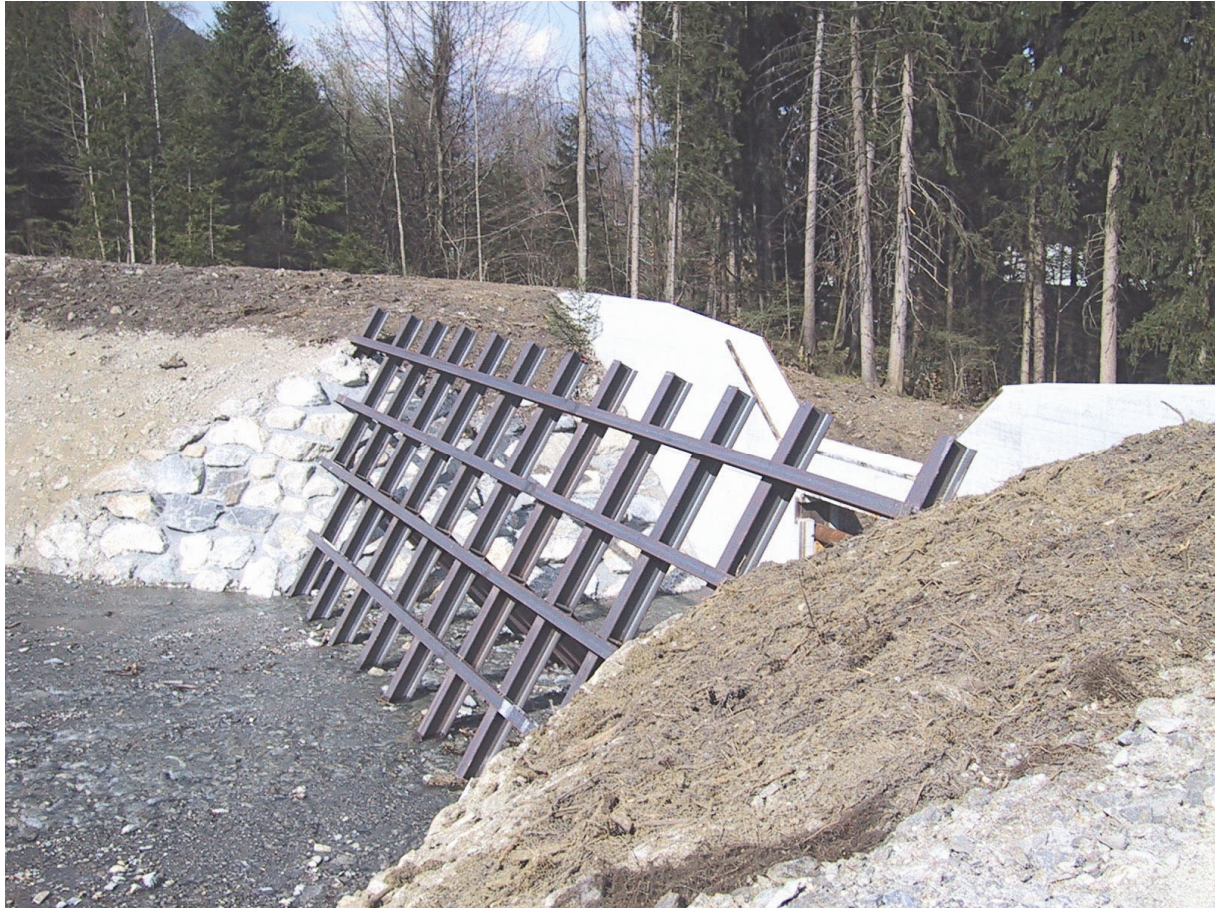
Abb. 92: der Abschlusssperre vorgelagerter Holrzückhalterechen am Heitibach (Quelle: Kissling + Zbinden AG)
