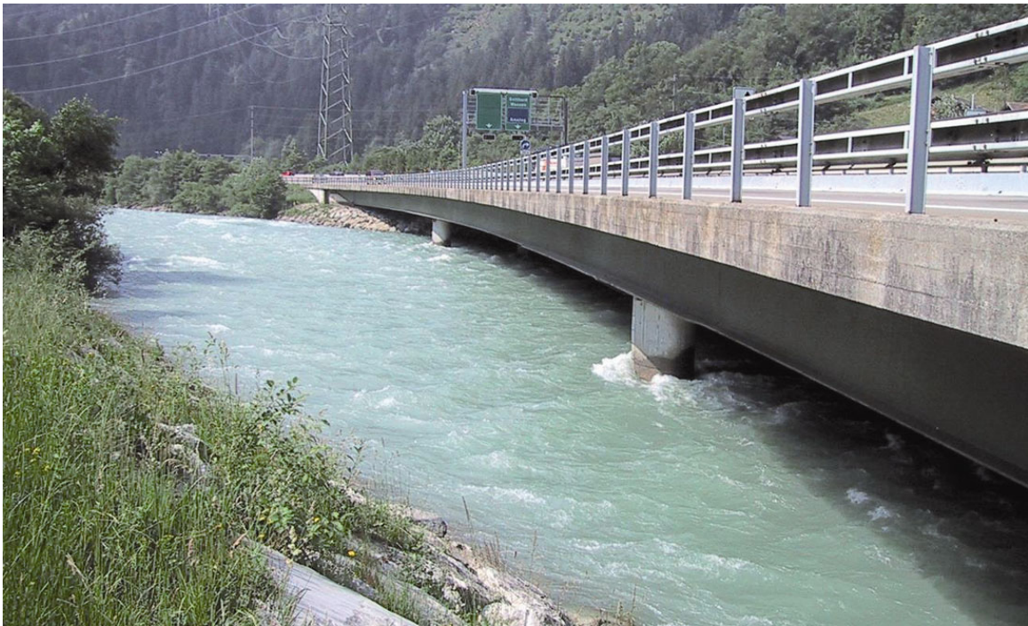
Abb. 16: Reussbrücke Grund zwischen Amsteg und Silenen mit knappem Freibord
