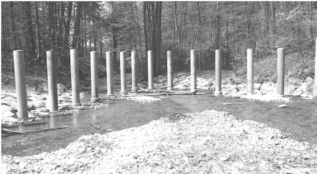
Abb. 88: V-förmiger Schwemmholzrechen am Chämptnerbach (Blick in Fliessrichtung)
