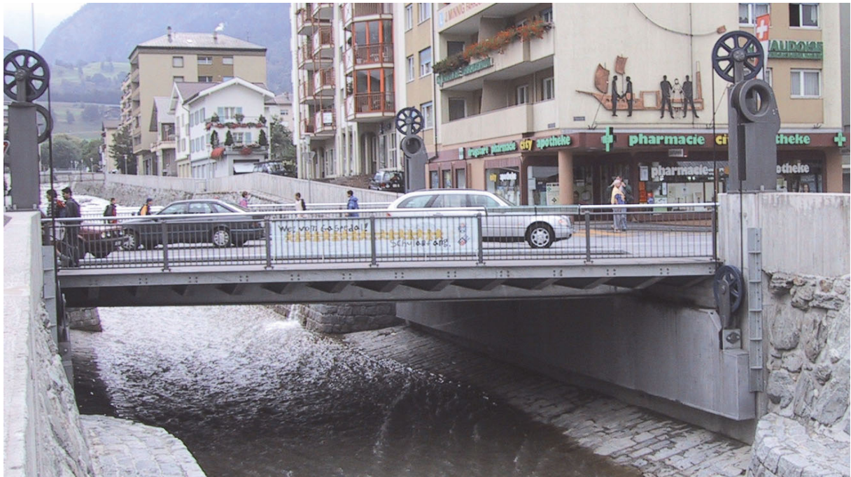
Abb. 22: Hubbrücke in Brig, in Normallage (Blick gegen Fliessrichtung)
