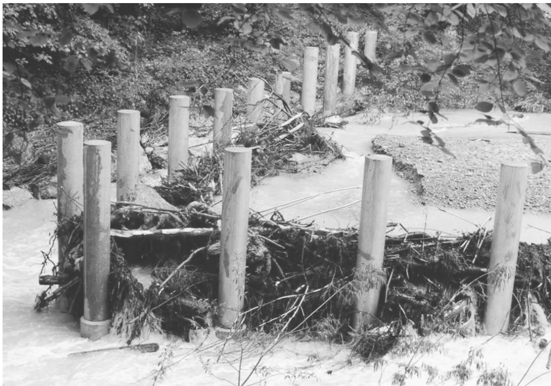
Abb. 89: Belastungsprobe für den V-Rechen beim Hochwasser vom 13. Mai 1999 (Quelle: Amt für Abfall, Wasser, Energie und Luft des Kantons Zürich)
