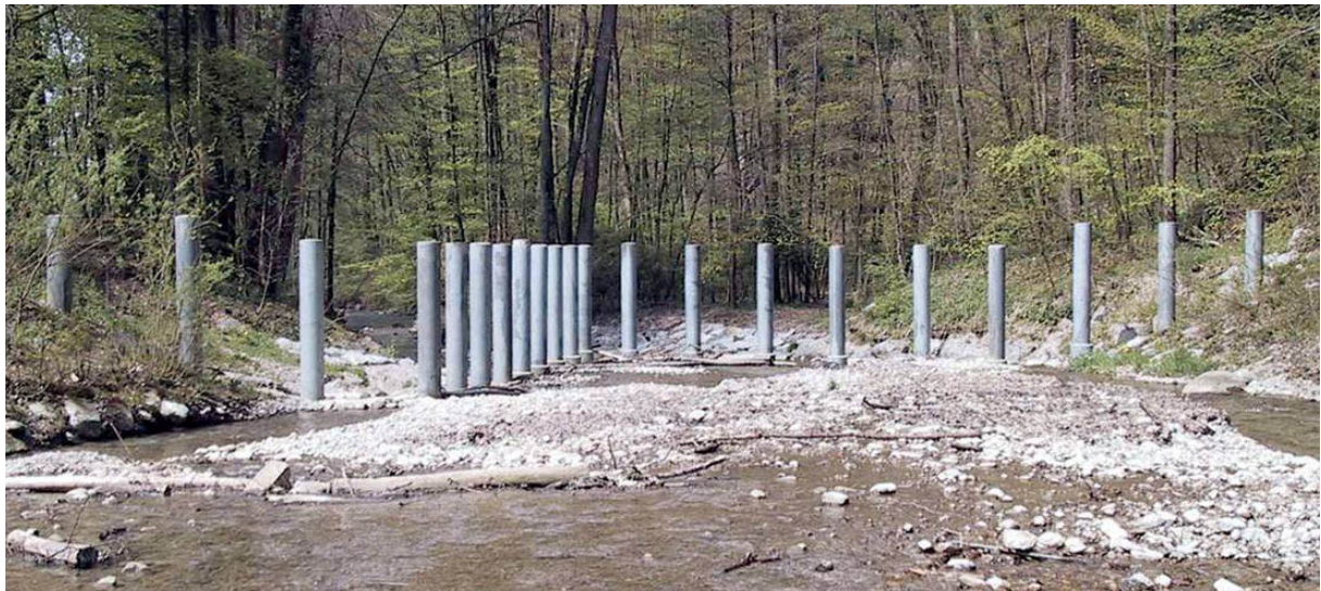
Abb. 29: V-förmiger Schwemmholzfang am Chämtnerbach (Kanton Zürich) im ausgeräumten Zustand, Stababstand 1.80 m (Blick in Fliessrichtung)
