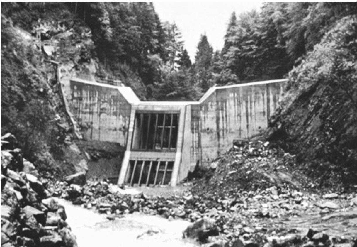
Abb. 35: Sortierwerk am Palanggenbach oberhalb von Seedorf im Kanton Uri
