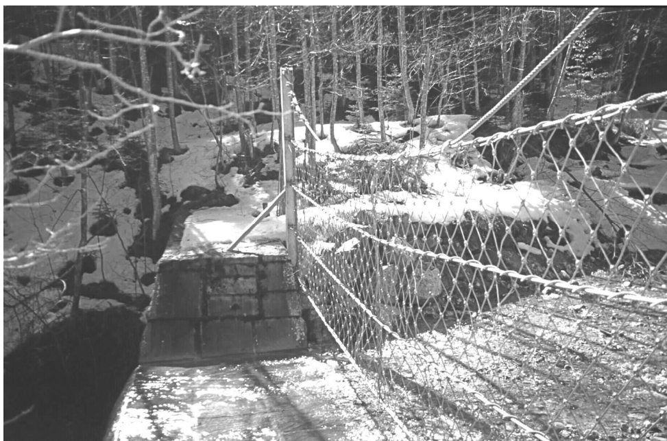
Abb. 54: Schwemmh Holznetz am Lahnenwiesgraben (Oberbayern); Fliessrichtung von rechts nach links (Quelle: Versuchsanstalt für Wasserbau und Wasserwirtschaft der TU München)
