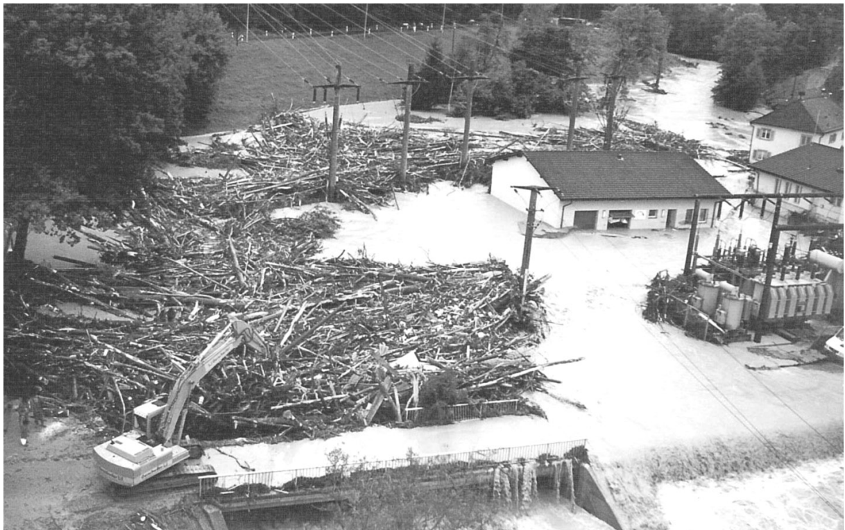
Abb. 2: Hochwasser 2002 an der Goldach im Kanton St. Gallen (Blick gegen Fliessrichtung) – vollständig verklauste Brücke, die Strommasten des Umspannwerkes übernehmen die Funktion eines Rückhaltereichens
