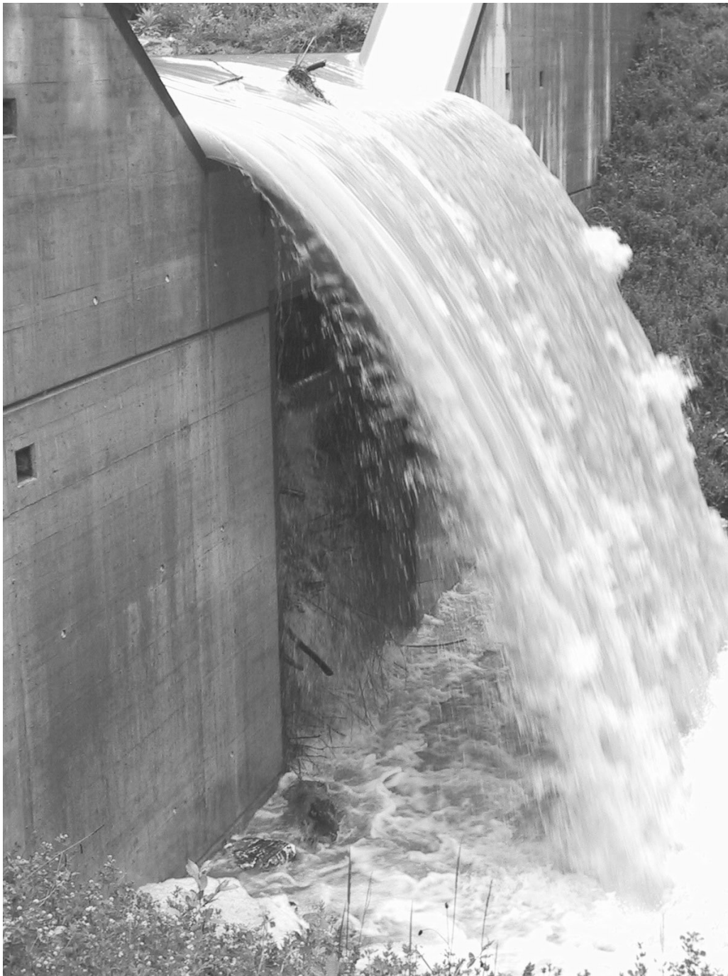
Abb. 94: Abschlussperre des Geschiebesammlers Heitibach beim Hochwasserereignis vom Juni 2004 (Quelle: Kissling + Zbinden AG)
