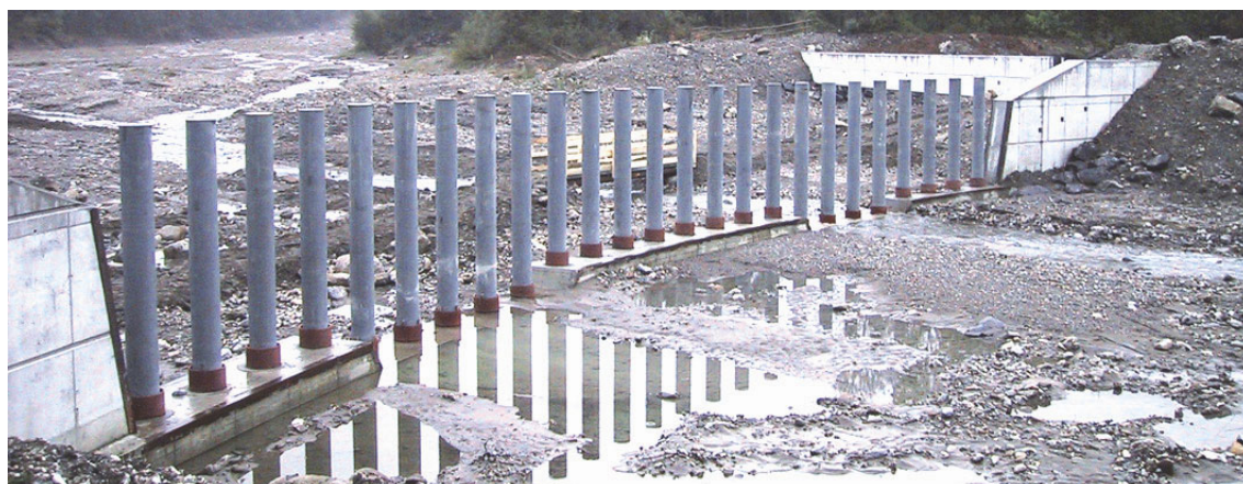
Abb. 76: Holzrückhalterechen an der Gürbe (Blick gegen Fliessrichtung)
