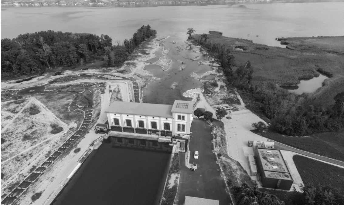
Abb. 2: Bauliche Vernetzung in Fluss-Landschaften – Neuer Auslaufkanal altes Kraftwerk Haggenbach (Photo: Energie Service Biel/Bienne (ESB))
