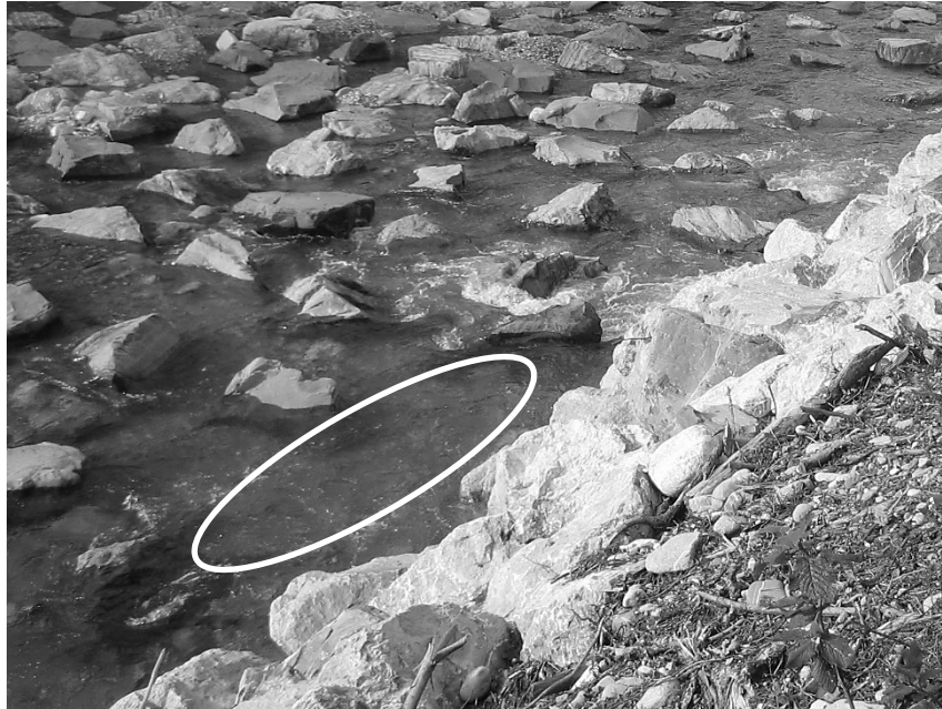
Abb. 2 Kolkbereich auf der Rampe «im Gand» (Kreis), Simme bei ca. 1 - 1.5 m 3 /s (27.10.2011)
