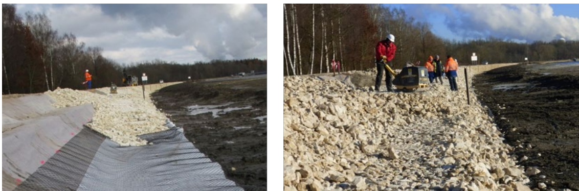
Abb. 6: Fertigstellung der Versuchsstrecke durch lageweisen Einbau des Schottermaterials
