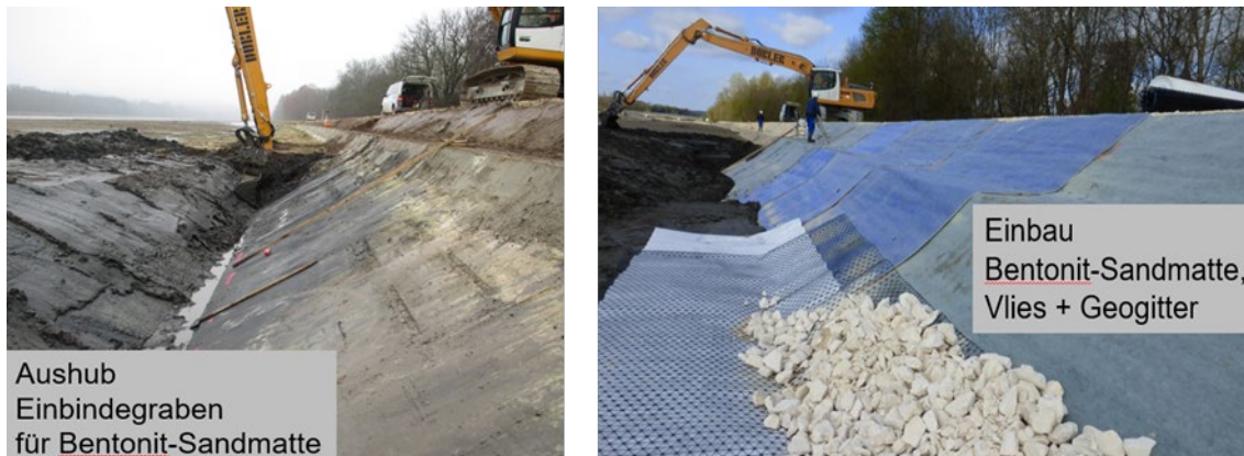
Abb. 5: Bau der „Öko-Berme“ in den Versuchsstrecken (Messeinrichtungen hier nicht im Bild)
