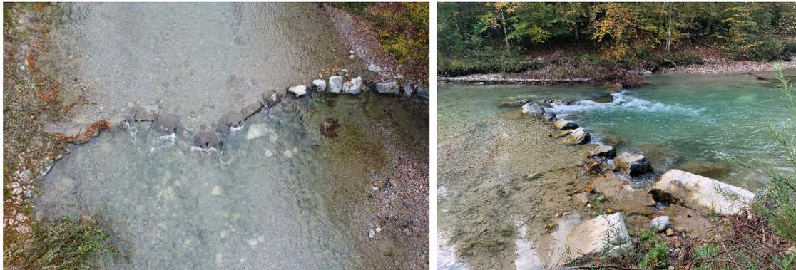
Abb. 1: Tiefe und Ausbildung von Kolken hängen stark von Riegelgeometrie ab (Beispiel Töss / Sennschür; Fotos: V. Neuhaus, IUB Engineering AG)
