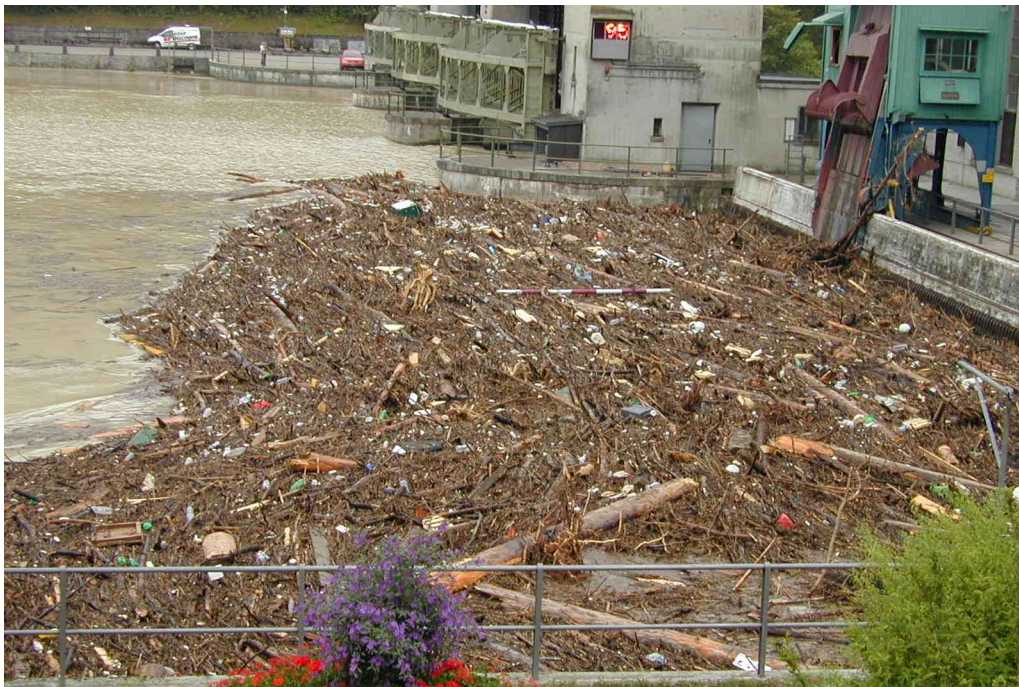
Fig. 1: Rechen beim Kraftwerk Reckingen (Quelle: RKR AG, 2024)
