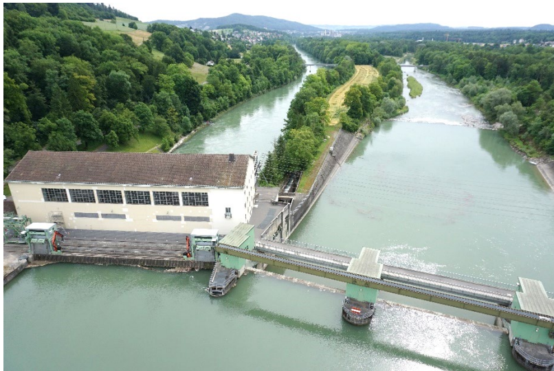
Abb. 1: Kraftwerk Rapperswil-Auenstein (Quelle: SBB)
