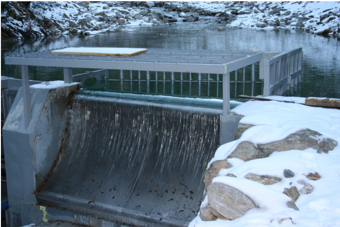
Abb. 1: Coanda-Rechen an einer alpinen Wasserfassung (Bild: www.htl-innovativ.at )
