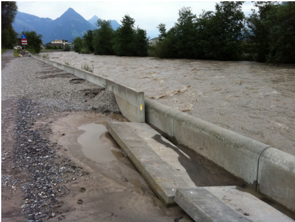
Abb. 1: Kippelemente an der Engelbergeraä (Bild: www.hochwasserschutz-ow.ch )
