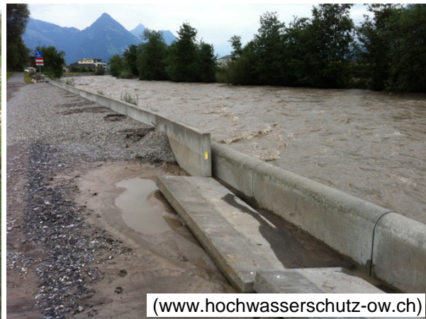
Abb. 1: Notentlastung als überströmbar ausgebildeter Dammbereich beim HRB Waldwimmersbach (D) und Kippelemente an der Engelbergeraas
