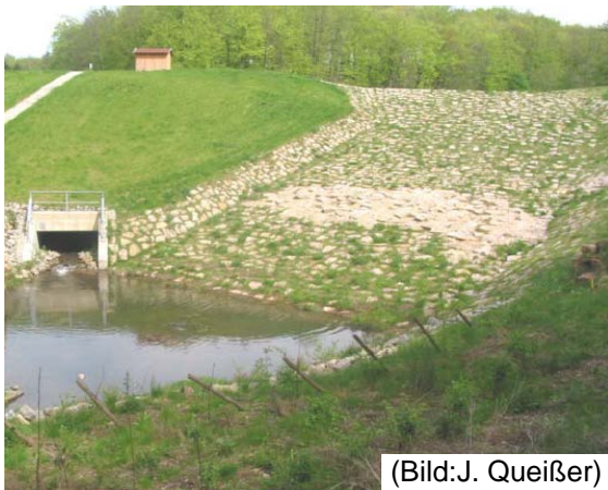
Abb. 1: Notentlastung als überströmbar ausgebildeter Dammbereich beim HRB Waldwimmersbach (D) und Kippelemente an der Engelbergeraas
