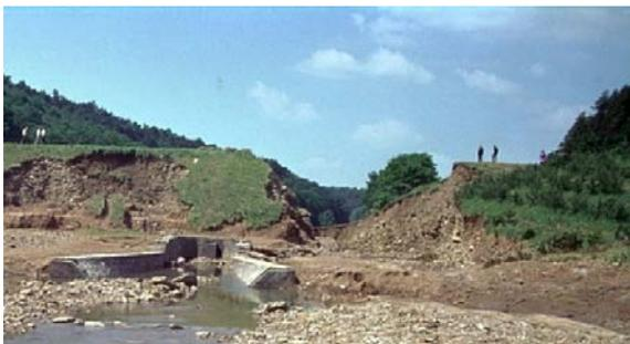
Abb. 1: Bruch des Erddamms eines Hochwasserrückhaltebeckens
