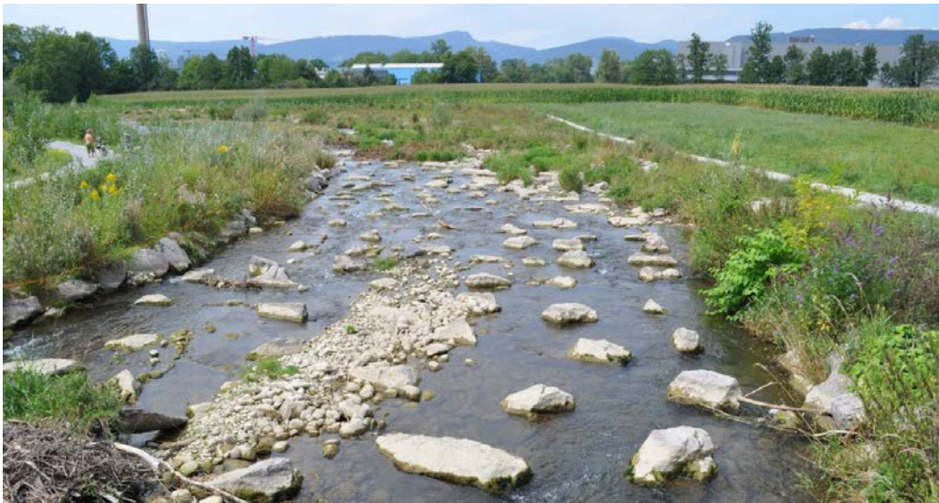
Abb. 1: Blockrampe an der Wyna, Kt. Aargau (Foto: S. Tamagni)
