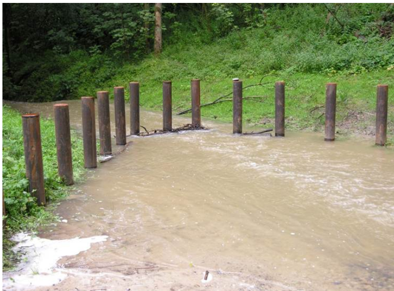
Abb. 1: Schwemmholzrechen Holderbach, Zürich-Affoltern (Quelle: B&H)
