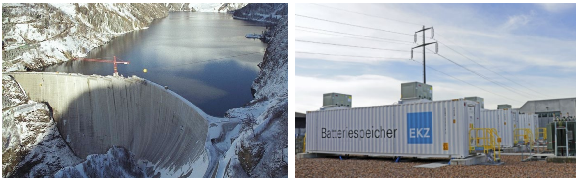
Abb. 1: a) Erhöhung der Bogenstaumauer beim Lago di Luzzzone (Quelle: Maggia) und b) Batteriespeicher Volketswil mit einer Leistung von 18 MW (Quelle: EKZ)
