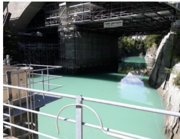
Abb. 2: Ausgleichsbecken beim Kraftwerk Göschenen mit engen Platzverhältnissen (Quelle: Axpo)
