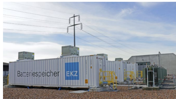
Abb. 1: a) Erhöhung der Bogenstaumauer beim Lago di Luzzzone (Quelle: Maggia) und b) Batteriespeicher Volketswil mit einer Leistung von 18 MW (Quelle: EKZ)
