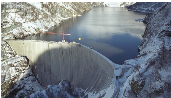
Abb. 1: a) Erhöhung der Bogenstaumauer beim Lago di Luzzzone (Quelle: Maggia) und b) Batteriespeicher Volketswil mit einer Leistung von 18 MW (Quelle: EKZ)
