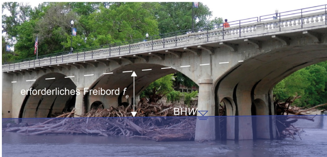
Abb. 1: Schwemmholzverklausung an einer Brücke mit gekennzeichnetem erforderlichem Freibord f_e zwischen dem Wasserspiegel beim Bemessungshochwasser (BHW) und der mittleren Kote der Brückenunterkante (Kansas, USA; Foto: Prof. Ellen Wohl)
