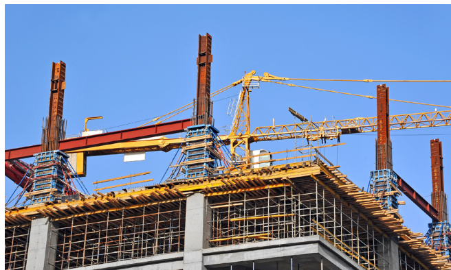
La construction va bon train en Europe
