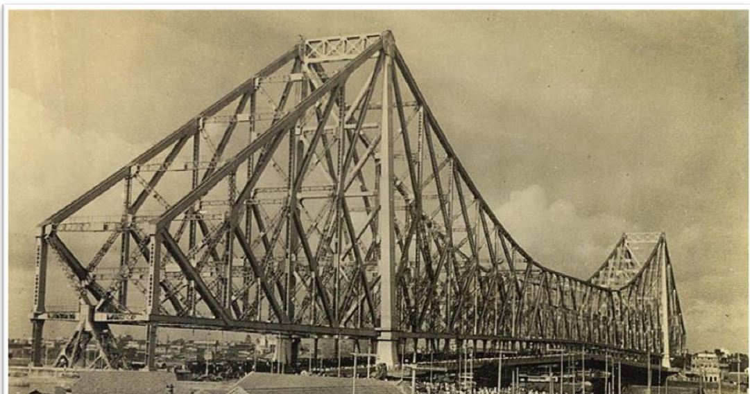
Tool of Empire? — Die Howrah Bridge in Calcutta (1943) gilt als Meisterleistung britischer Ingenieurskunst
