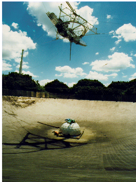
Abbildung 11 : Feste Parabolantenne für die Radioastronomie in Arecibo (Puerto Rico). Der Spiegel befindet sich in einem Vulkankrater (Durchmesser 303 m, durchschnittliche Oberflächenrauigkeit 2.2 mm). Das Bild zeigt das aktuelle Gregory-Antennensystem (der Hyperbolspiegel hängt "hinter" dem Brennpunkt, der Empfänger befindet sich im Radom – mit Radom bezeichnet man ein Gehäuse aus Kunststoff, das die Antenne umgibt und sie vor Witterungseinflüssen schützt – in der Mitte des Primärspiegels). Typischer Frequenzbereich 0.3-8 GHz, Gewinn 80 dB (dies ist die gewinnstärkste Antenne der Welt!) bei 8 GHz.
