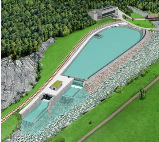
Schwalldämpfungsbecken bei Innertkirchen BE (Visualisierung); Bauzeit 2012–2016.
