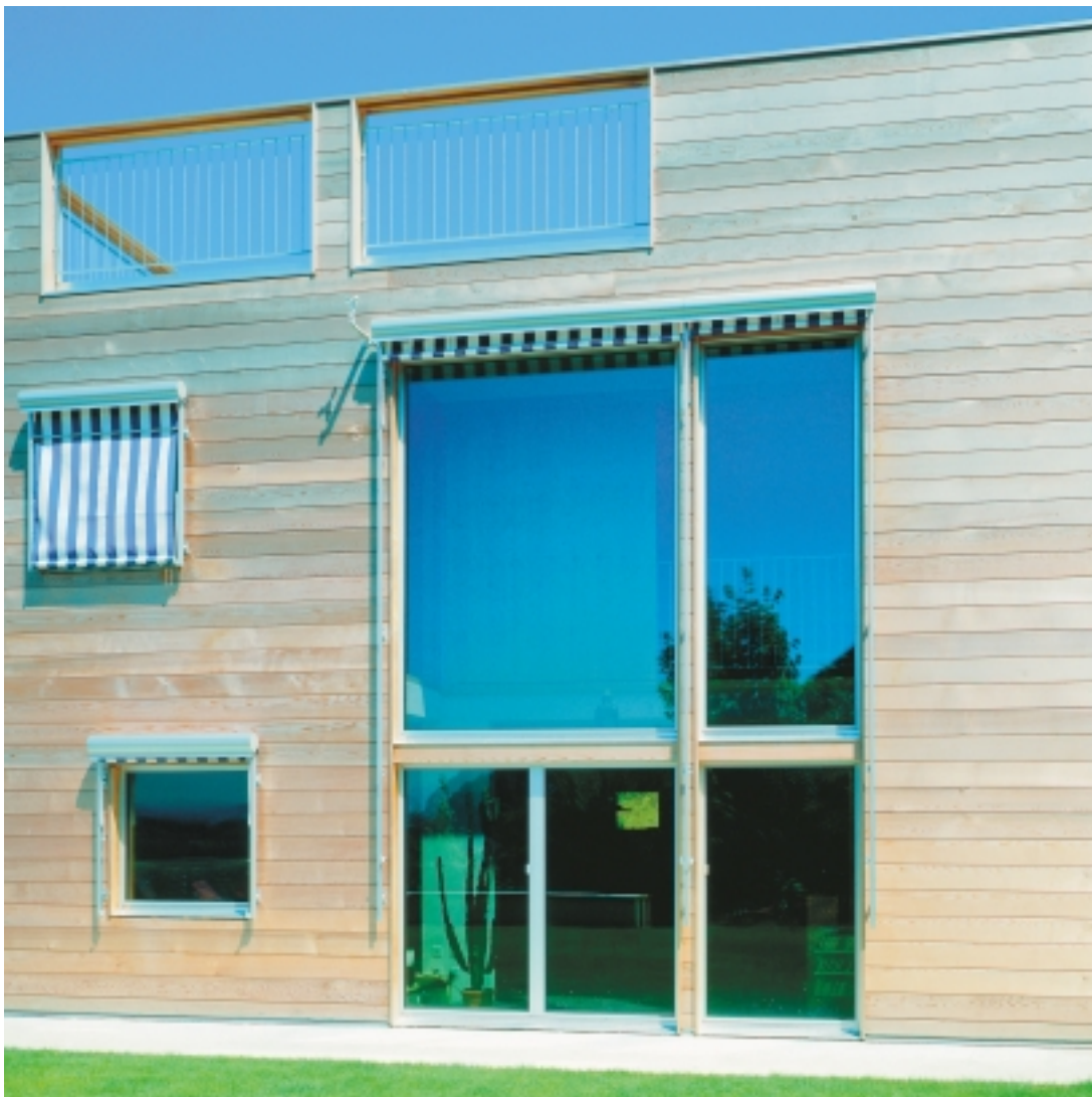
Grosse Fensterflächen gegen Süden gewinnen Sonnenwärme, und ein externer Sonnenschutz verhindert Überhitzung im Sommer.
