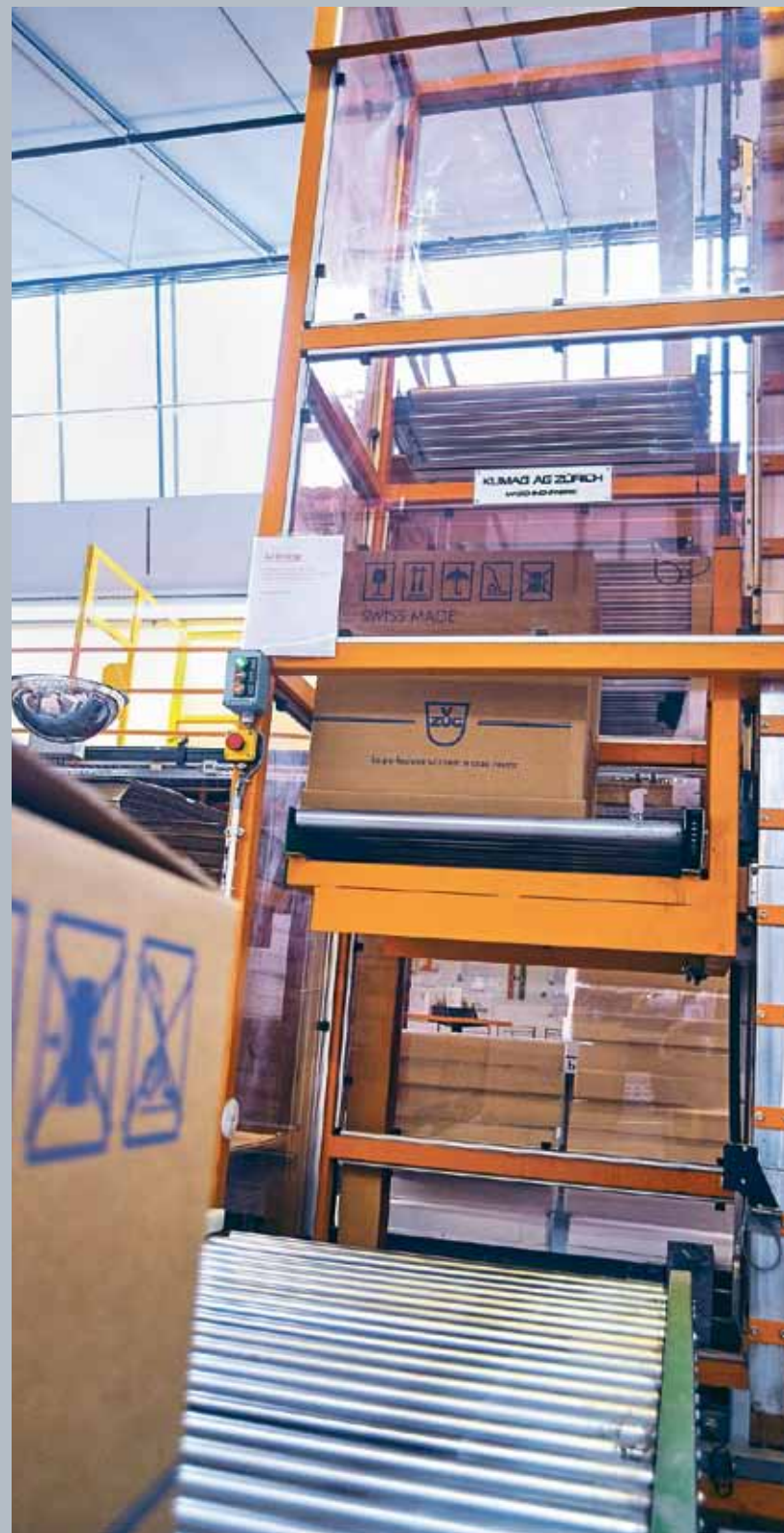
Warenaufzug: Der Transport ins Logistikzentrum ZUGgate erfolgt automatisch über einen Warenaufzug.
